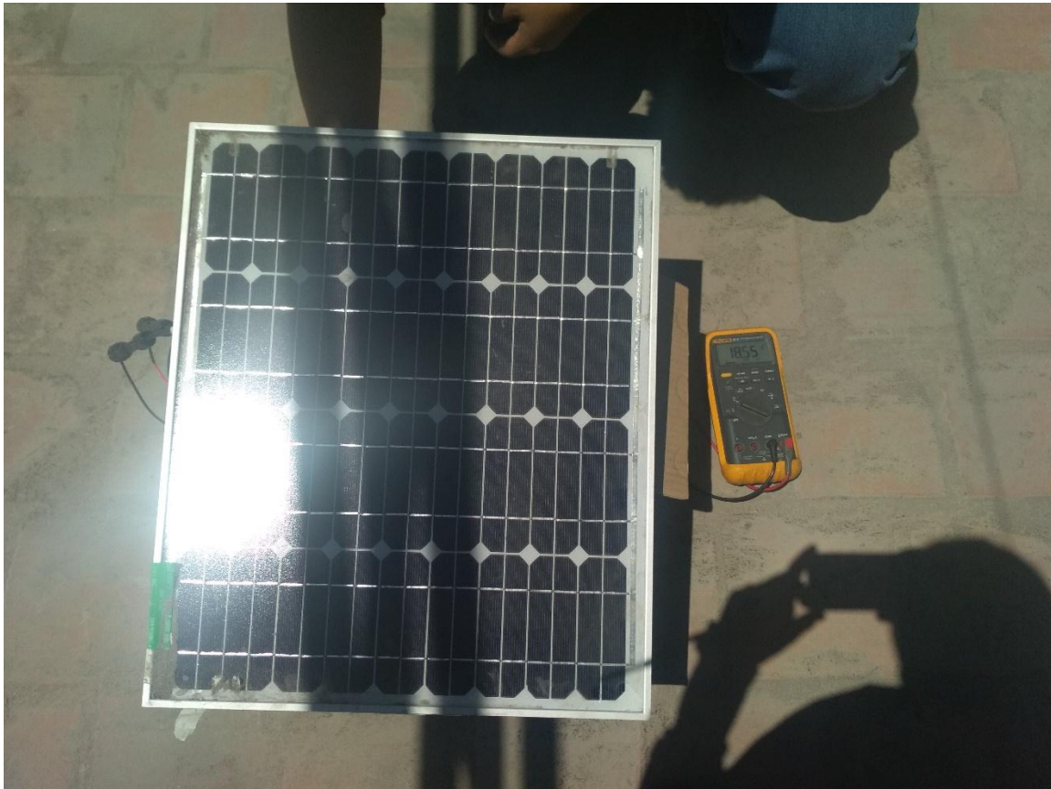
Ilustración 58 Panel ensombrecido por barras verticales. Lectura de voltaje 18.55
