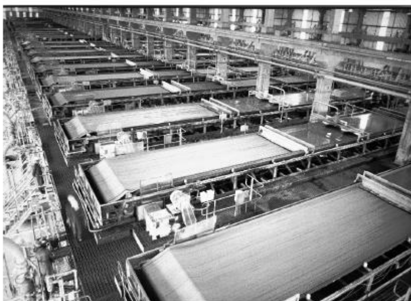
Planta con filtros de banda horizontales más grande del mundo con 26 filtros de 80 m 2 cada uno.
