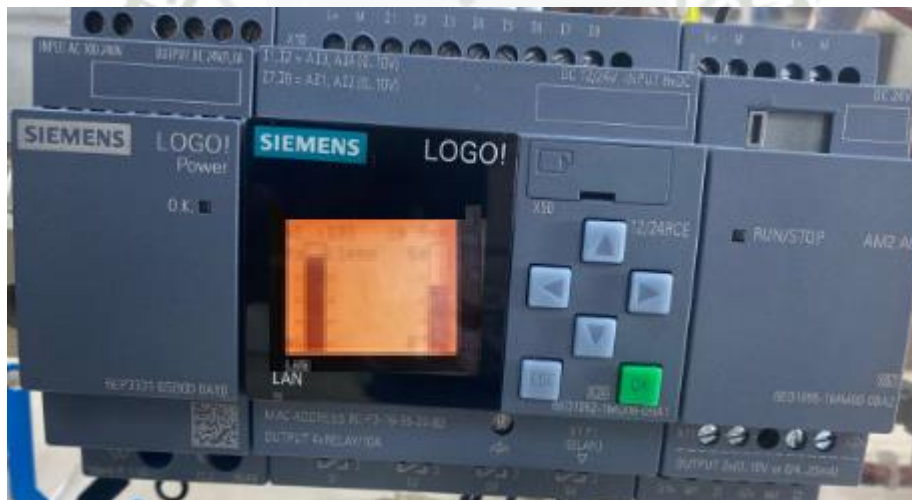
Figura 51. Energizado del PLC mediante 220Vac.
