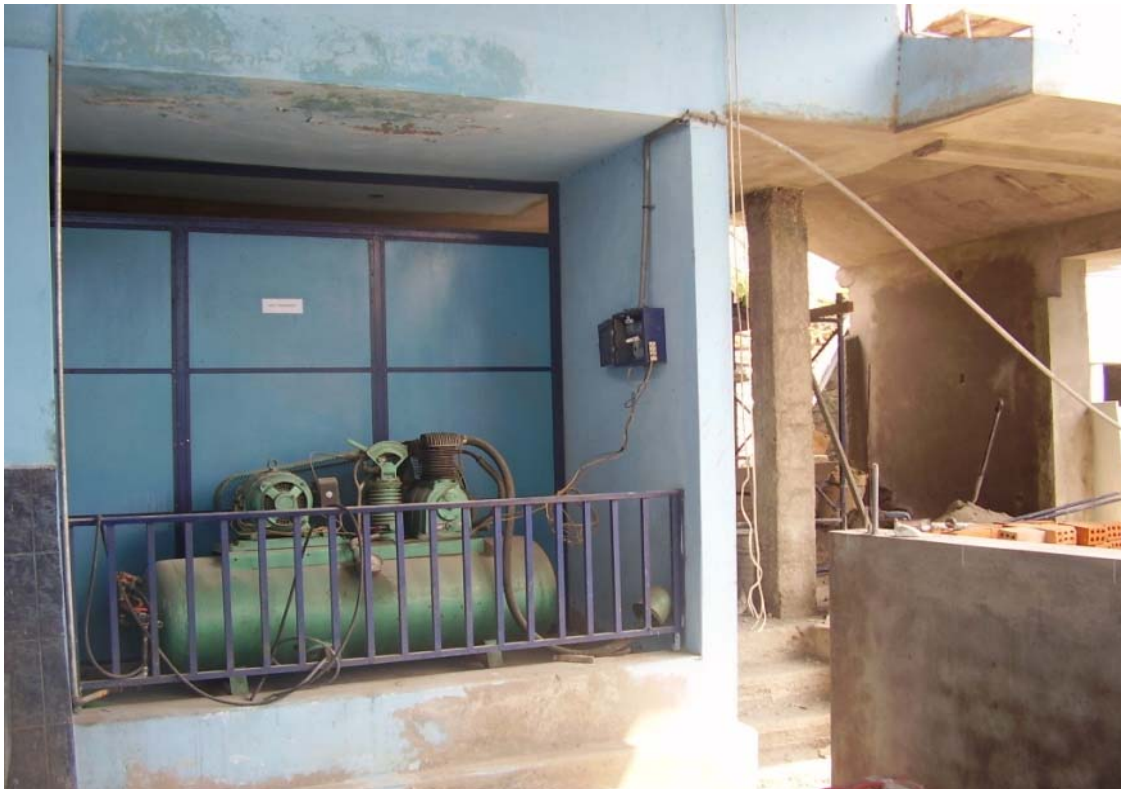
Área Electrodeposición, Pintura y Acabados (Exterior)
