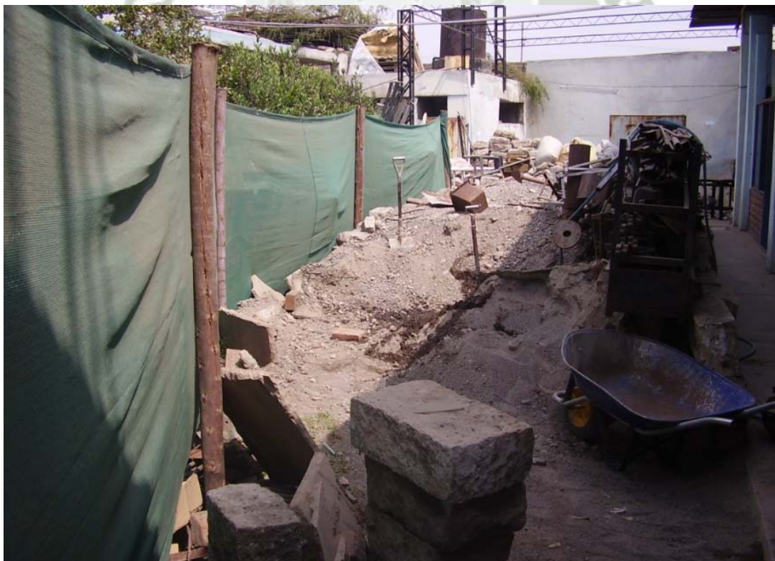
Área libre en proceso de implementación como área de Electrodeposición
