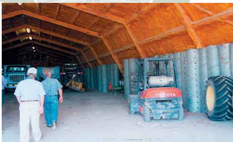
FIGURA N° 6 VISTA INTERIOR DE UN ALMACÉN CON VENTILACIÓN FORZADA
