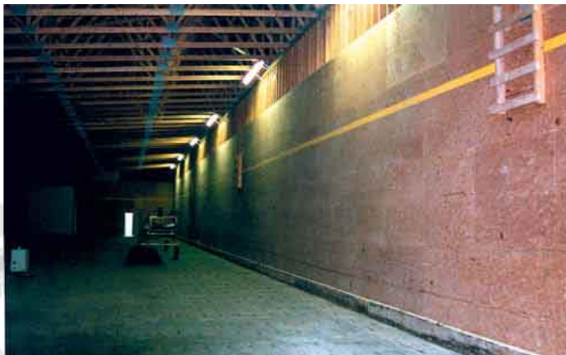
FIGURA N° 5 INSTALACIONES PARA EL ALMACENAMIENTO CON VENTILACIÓN FORZADA.
