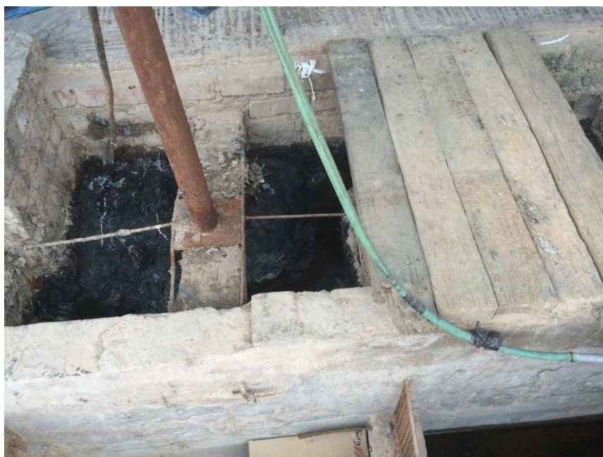
Figura N°7: Pozos de sedimentación
