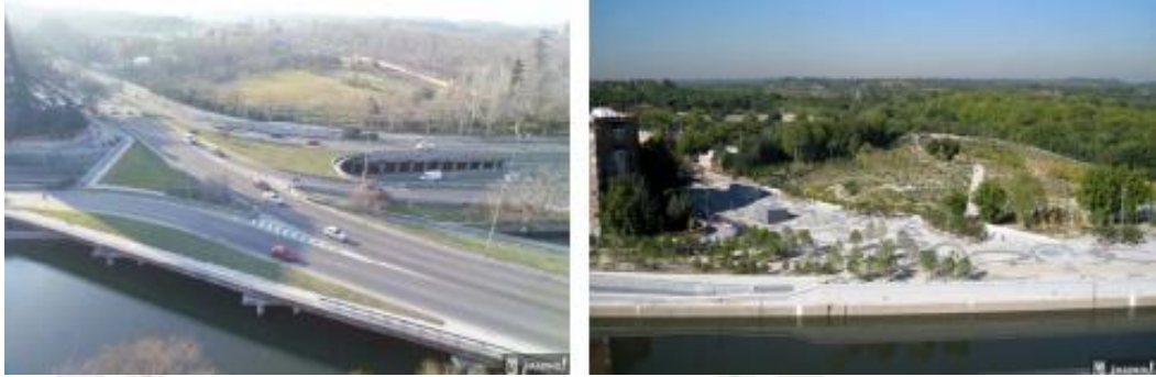
Figura 6. El antes y después de la intervención del proyecto (1). Fuente: Gauna, Nazar & Taborda (2012).
