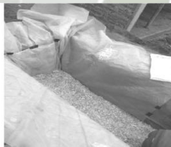
FOTOGRAFIA 8 ACOLCHONAMIENTO CON PAJA DE LA ZANJA FOTOGRAFIA 7 ACOLCHONAMIENTO CON ASERRIN DE LA ZANJA
