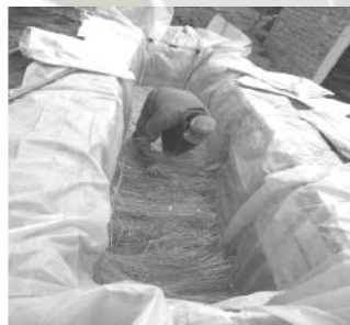
FOTOGRAFIA 8 ACOLCHONAMIENTO CON PAJA DE LA ZANJA FOTOGRAFIA 7 ACOLCHONAMIENTO CON ASERRIN DE LA ZANJA
