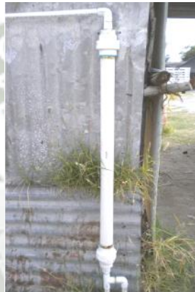
Figura. 16 Filtro de H_2S
