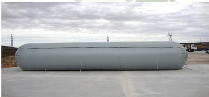
Figura 22. Bolsa para metano en la Planta de Biodigestion.
