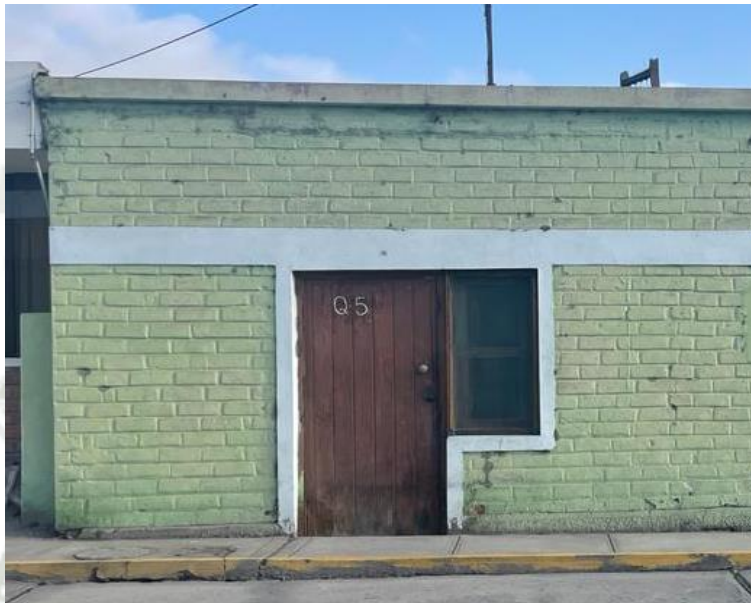
Figura 86 Muro de ladrillo caravista
