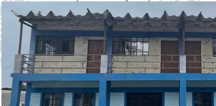
Figura 97 Balcón con barandas y columnas de fierro y concreto
