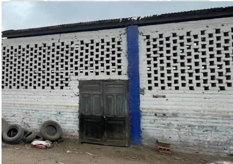
Figura 87 Muro de ladrillo caravista con trama de vacíos
