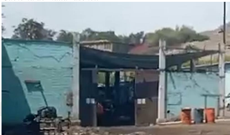
Figura 115 Cubierta de malla raschell
