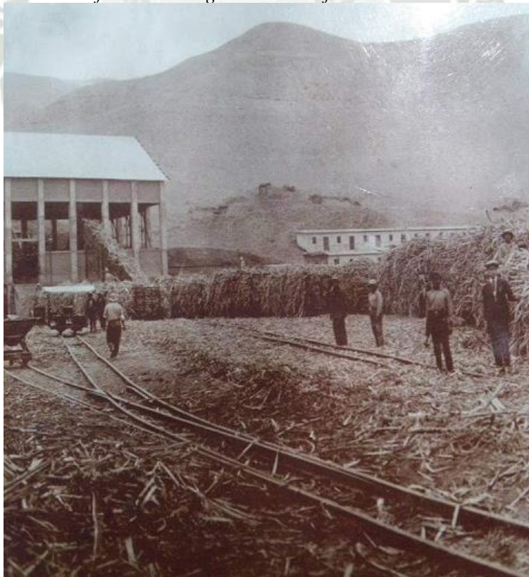
Figura 15 Líneas del ferrocarril ingresando a la fabrica
