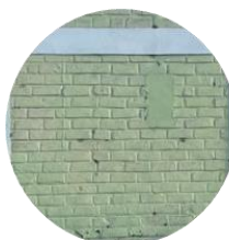
Muro ladrillo caravista
