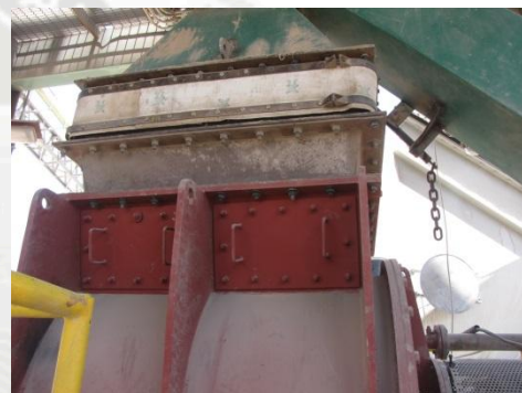
Fig. 1 Ventanas de Inspección.
