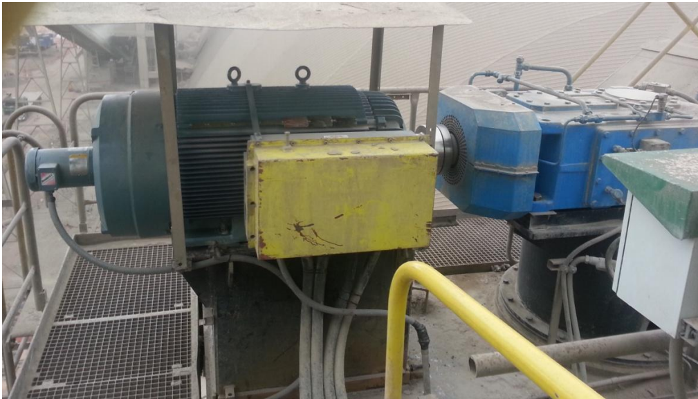
Imagen n° 14: Foto del motor de 551 amperios y otra foto de su placa de fabricación.
