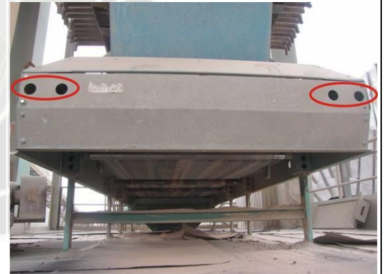
Fig. 1 Orificios de inspección en polea de cola
