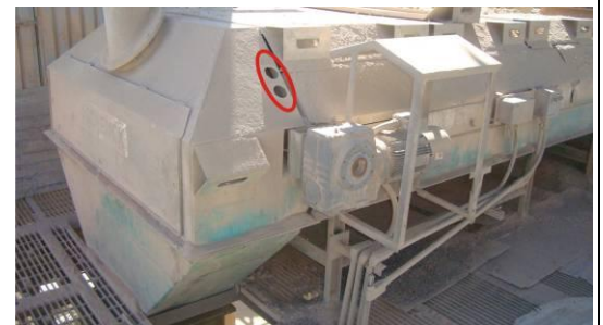
Fig. 2 Orificios de inspección en la polea motriz
