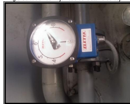
Fig.4 Flujómetro indicando 140 Litros/minuto.
