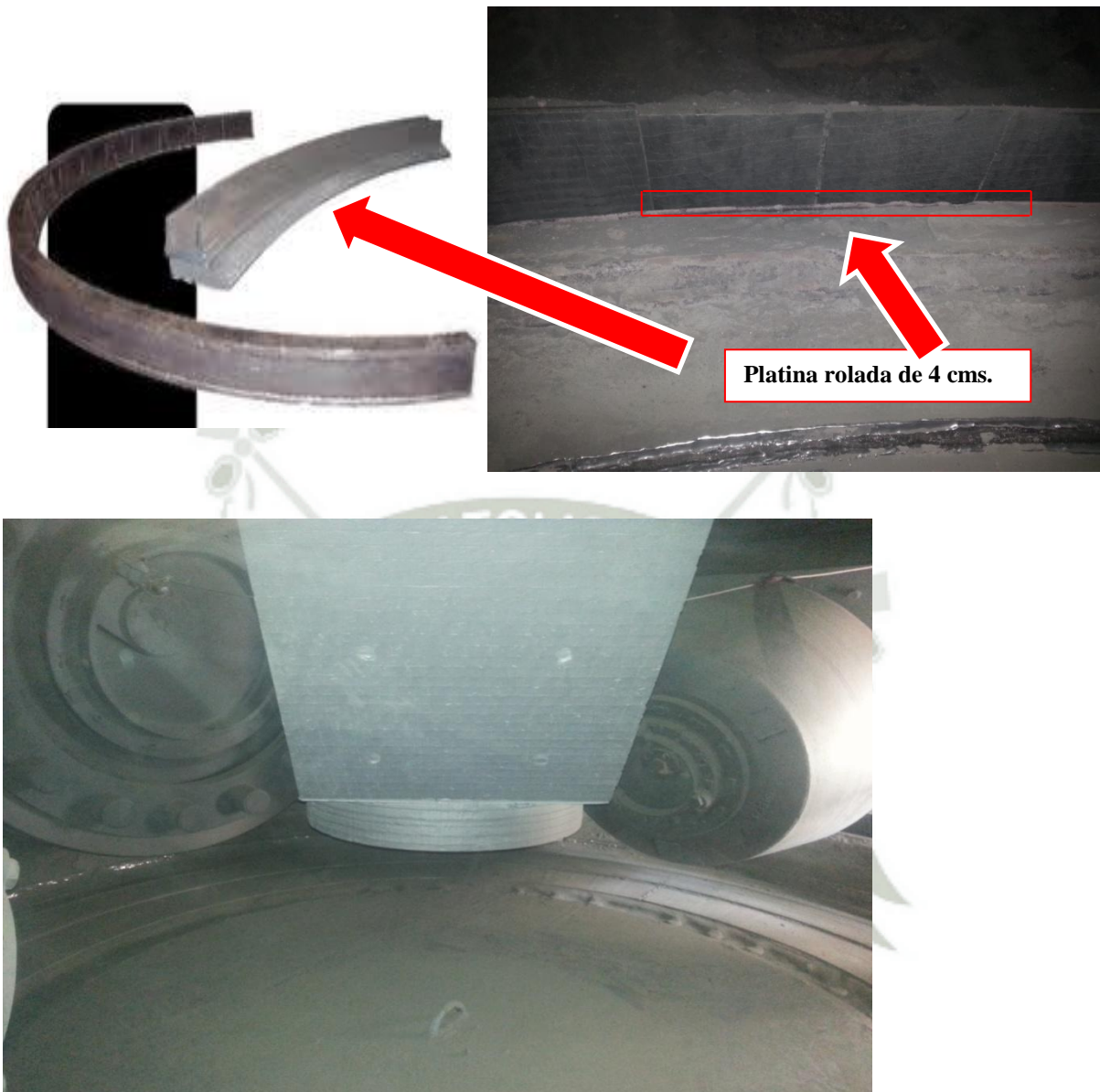
Imagen n° 13: Fotos del dam ring del molino vertical de cemento.
