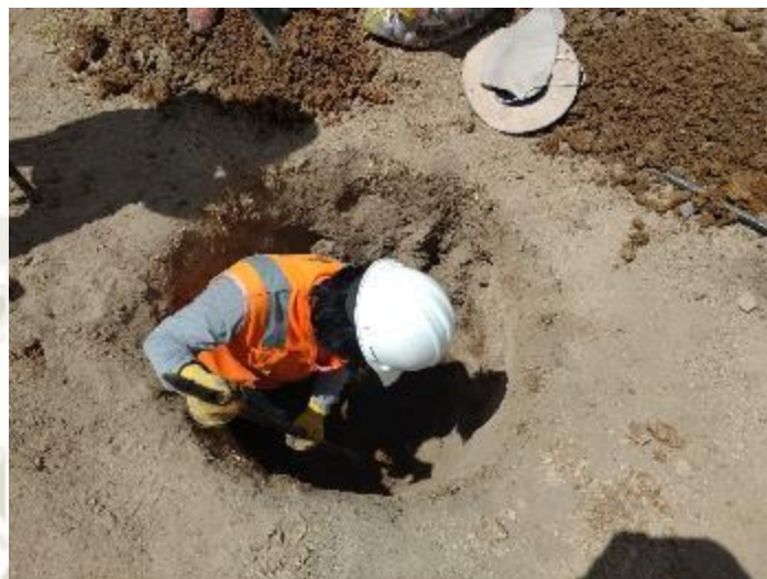
Figura 21: Excavación de calicata 1 Fuente: Elaboración propia
