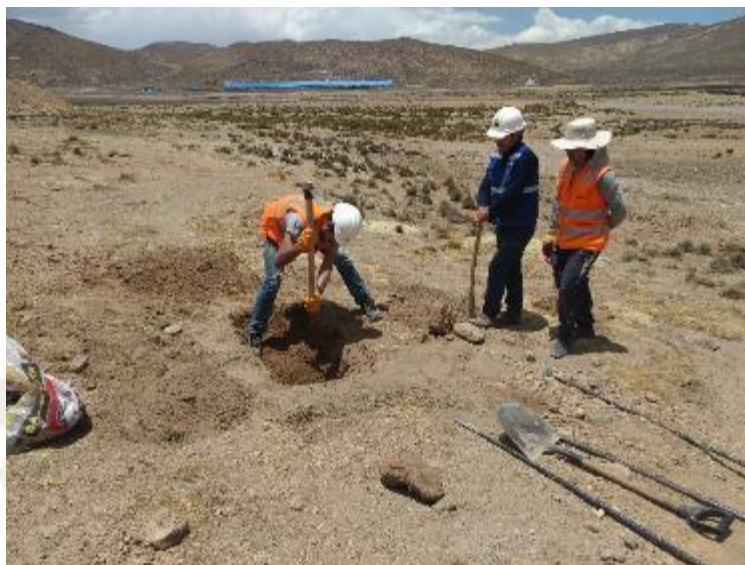
Figura 23: Excavación calicata 2 Fuente: Elaboración propia
