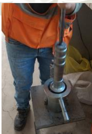
Figura 6: Compactación de mezcla asfáltica en caliente Fuente: Elaboración propia
