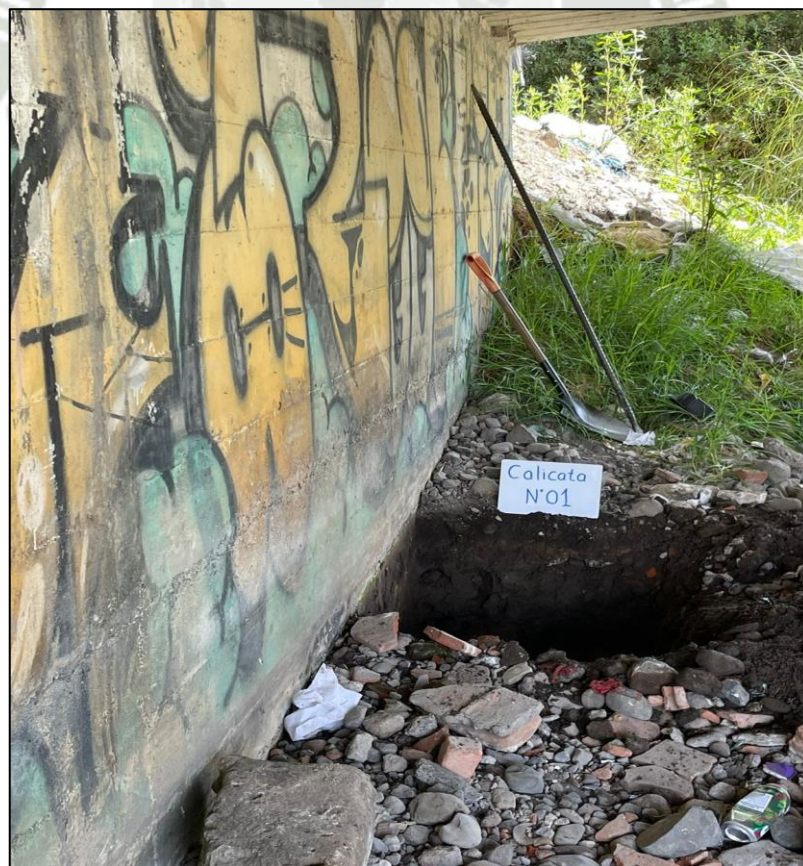
Figura 6.1 Punto N°1 en el estribo del margen derecho del puente San Martín
