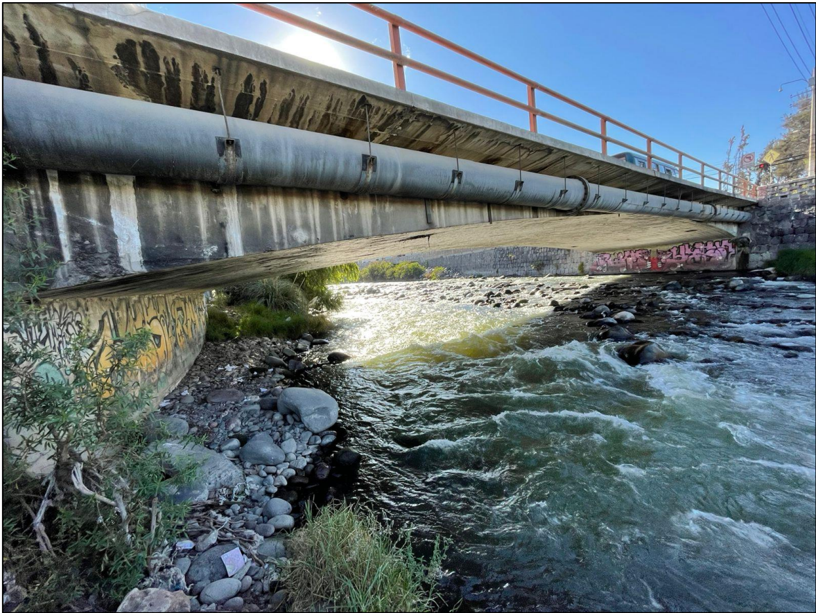
Figura 3.4 Puente San Martín visto desde el cauce del río en su margen derecha
