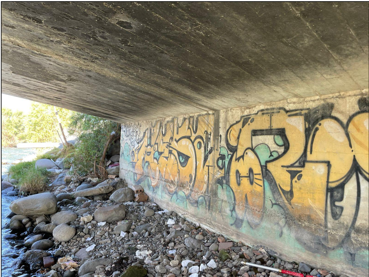
Figura 3.6 Estribo derecho del puente San Martín
