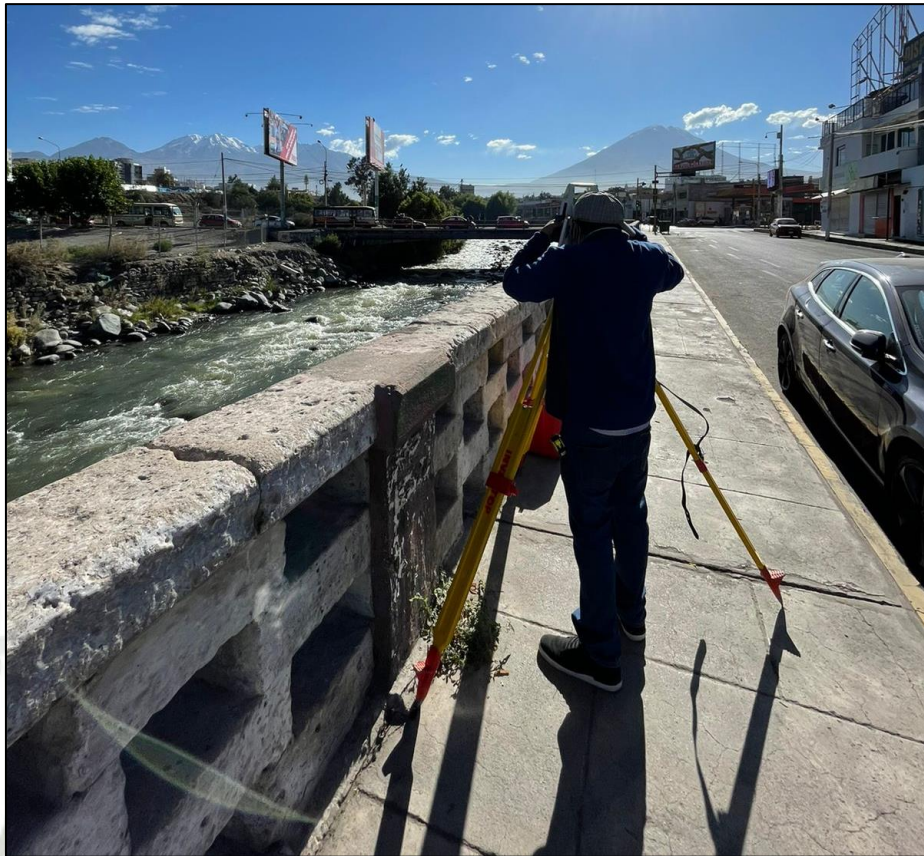
Figura 5.3 Levantamiento topográfico del puente San Martín (aguas abajo)
