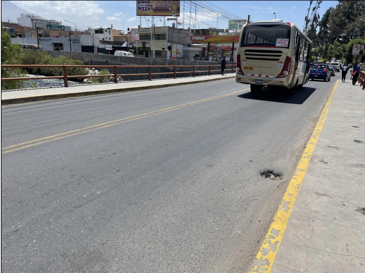
Figura 3.8 Estado actual de pavimento del Puente San Martín
