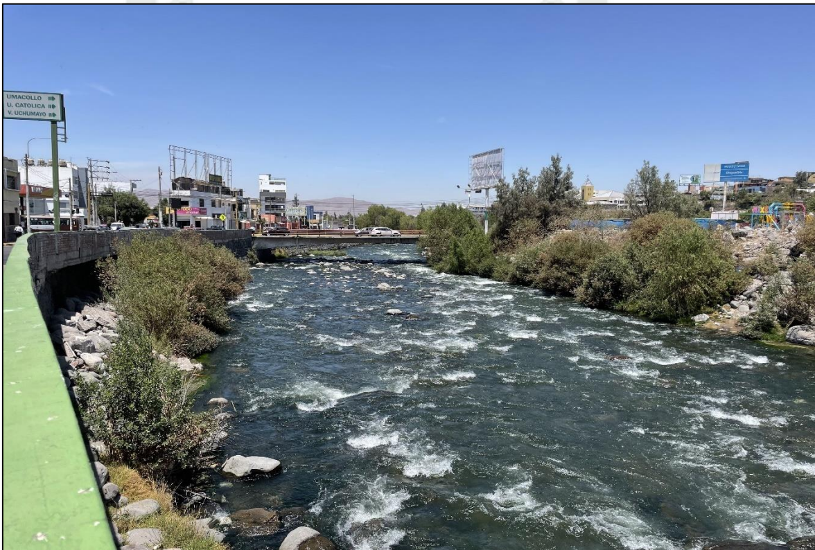
Figura 3.3 Vista aguas arriba del puente San Martín
