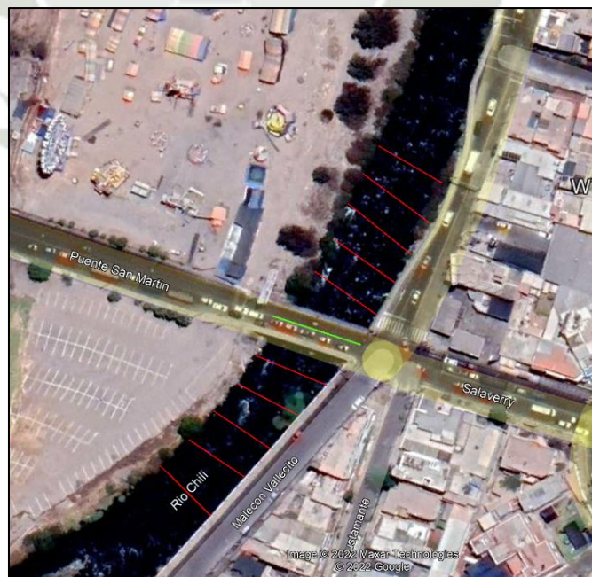
Figura 5.2 Ancho de cauce principal cercano al puente San Martín
