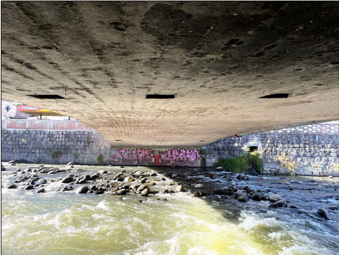
Figura 3.7 Estribo izquierdo del puente San Martín
