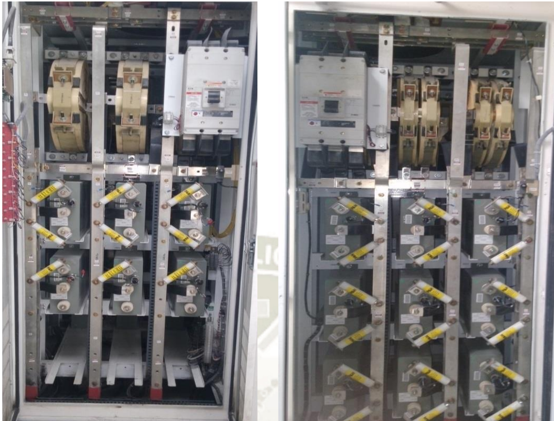
Figura 2-24: Gabinete RPC Banco 1/2 (izquierda) y Gabinete Banco full 1,2 y 3 (derecha).
