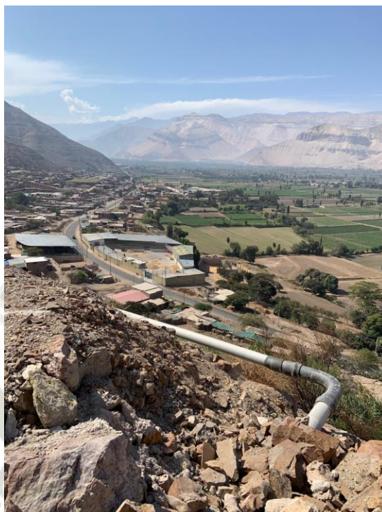
Fotografía 5. Vista de los anexos de El Monte, Cochate y La Real.
