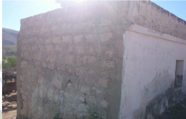
Figura 174 Vivienda de sillar construida con elementos de confinamiento
