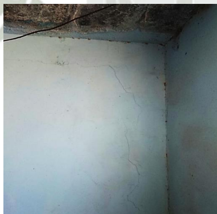
Figura 140 Grieta en muro de albañilería Vivienda SA-01
