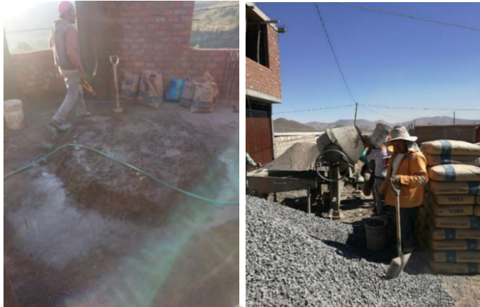
Figura 52 Mezcla para el vaciado de columnas hecha manualmente S-01 (Izquierda); Mezcla del concreto para losa realizada en una mezcladora de 9 pies 3 SA-01 (Derecha)
