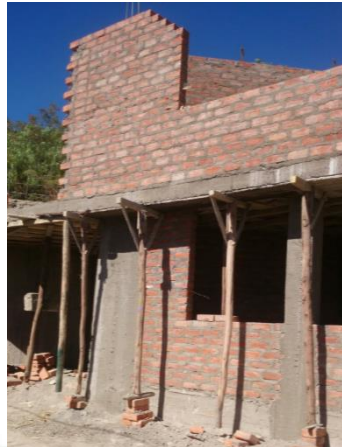
Figura 63 Encofrado de fondo de viga de 9.20 m en el 10mo día de encofrado S-01.
