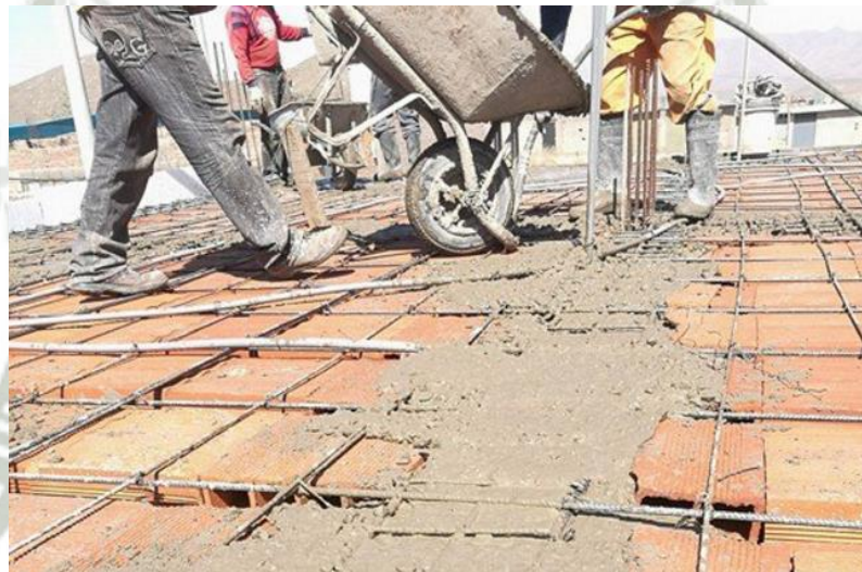
Figura 54 Vibrado mecánico en losa S-02
