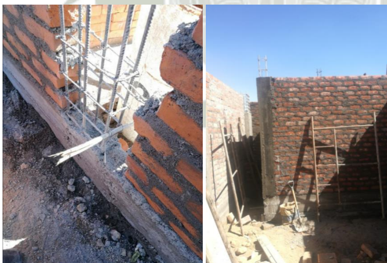
Figura 57 Sobrecimiento vaciado el parte baja de columna SA-03 (Izquierda); Columna de confinamiento vaciada empieza sobre el sobrecimiento SC-02
