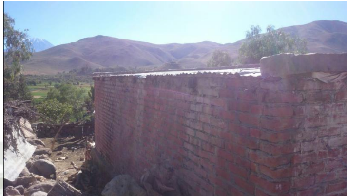
Figura 139 Vivienda sin confinamiento CH-02.
