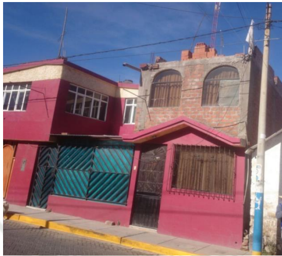
Figura 163 Ubicación de vano no constante en vivienda de Yarabamba
