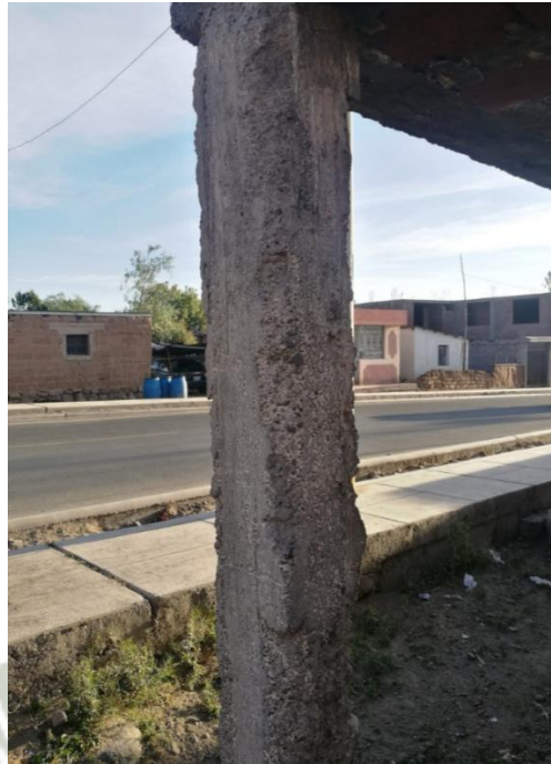
Figura 169 Parte frontal de la vivienda SA-17 se parecía el desnivel respecto a la vía pública.
