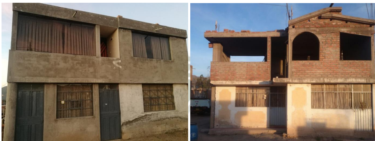
Figura 165 Toma frontal de viviendas SA-19 Y SA-15.
