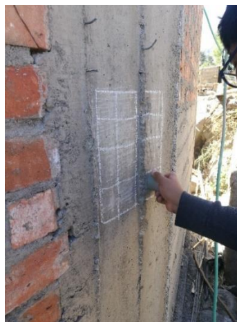
Figura 117 Procedimiento de limpieza superficial del elemento estructural para el ensayo de Esclerómetro.
