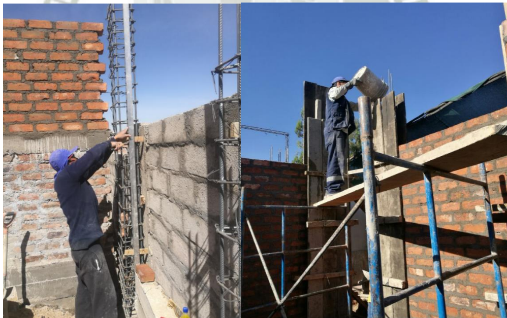
Figura 83 Peón realizando el ajuste del nivel sin la debida protección en las manos SC-02 (Izquierda); Peón realizando el vaciado de una columna con la adecuada protección en las manos SC-01 (Derecha)
