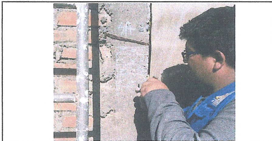
DESCRIPCIÓN: Ensayo de Esclerómetro en Columna de Confinamiento
