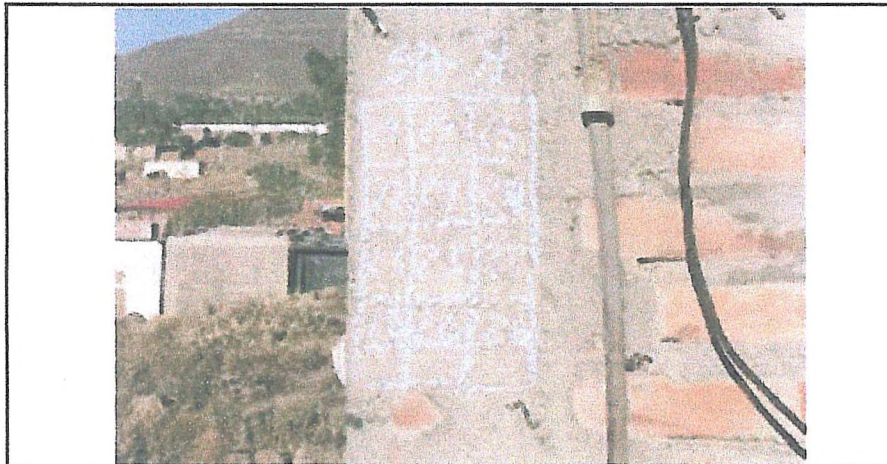
DESCRIPCION: Ensayo de Esclerómetro en Columna de Confinamiento
