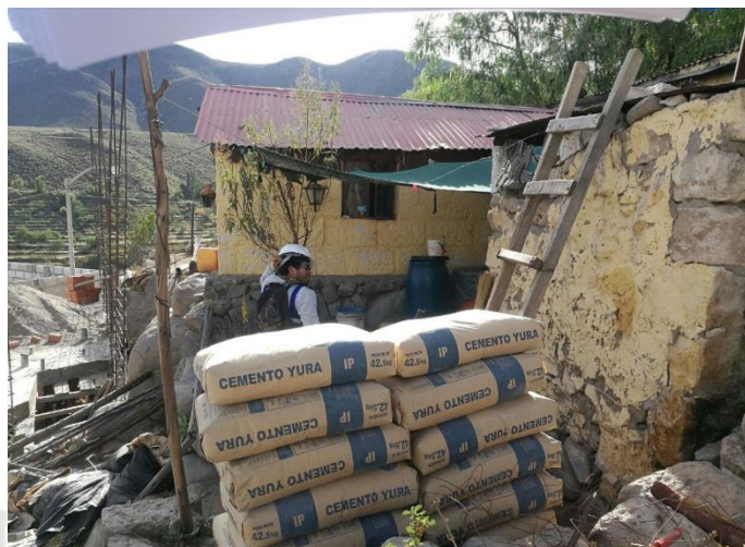
Figura 168 Vivienda ubicada en la ladera de un cerro S-01
