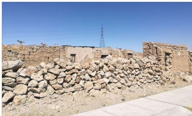
Figura 6 Vivienda de sillar afectada por el sismo de 1958, abandonada (Ref. propietaria Silvia Málaga.)
