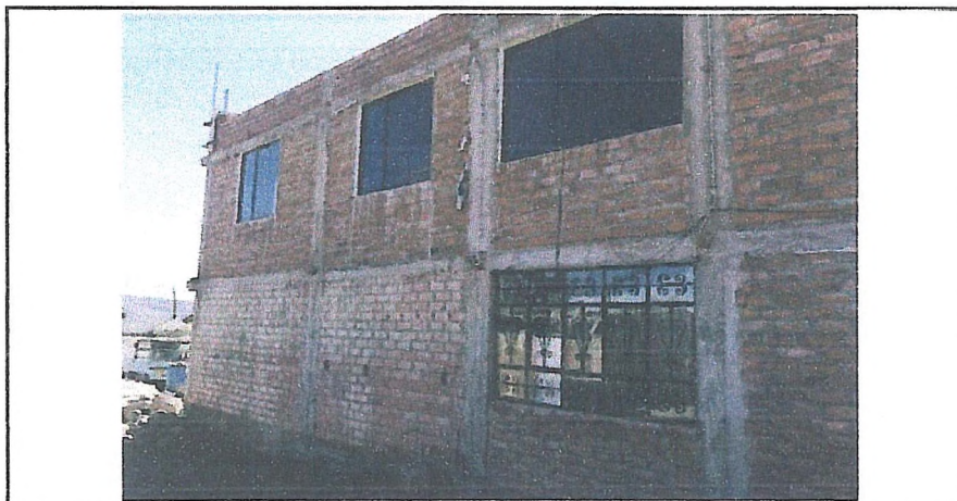
DESCRIPCIÓN: Vista Lateral de la Vivienda, lugar donde se hizo el ensayo de esclerometría.
