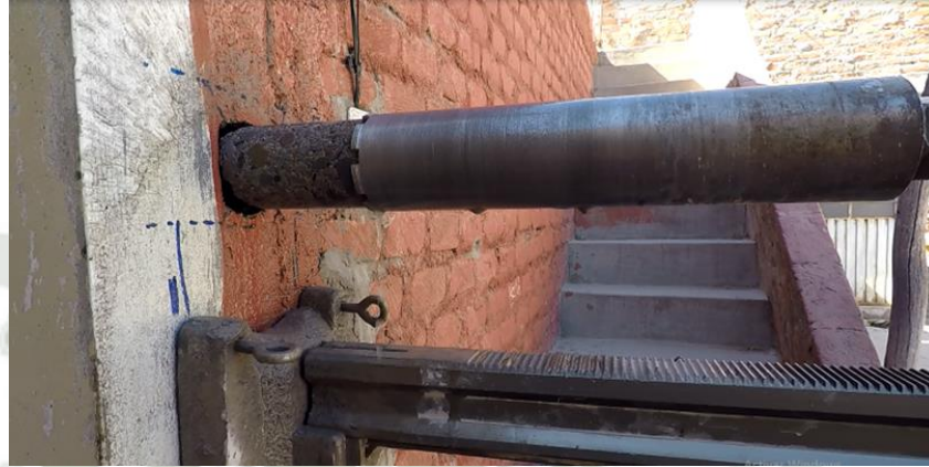
Figura 115 Extracción del Testigo de 3" de Diámetro en el Anexo el Cerro.
