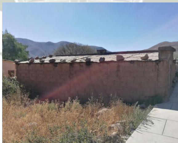
Figura 175 Muro de adobe, con mortero de barro (SA-02)
