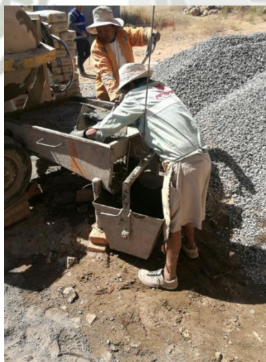
Figura 81 Peón laborando con ropa y calzado inadecuado SA-01 (Izquierda); Peón con la debida indumentaria y calzado SC-01 (Derecha)
