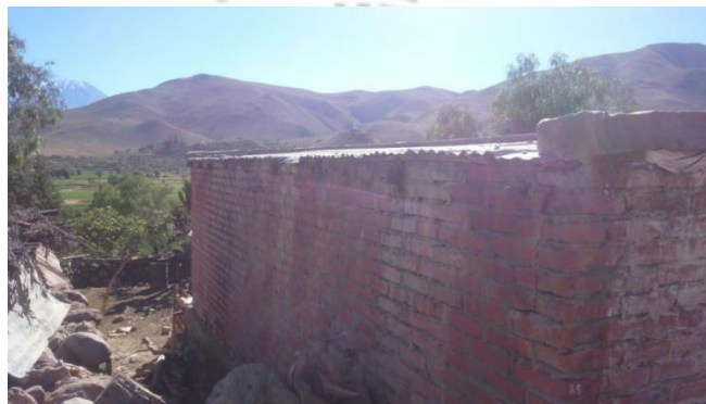
Figura 149 Vivienda CH-02, se aprecia la fijación de la calamina con concreto en el perímetro
