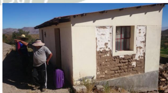
Figura 125 Vivienda CH-03, de adobe y sillar, asesoramiento en construcción SENCICO
