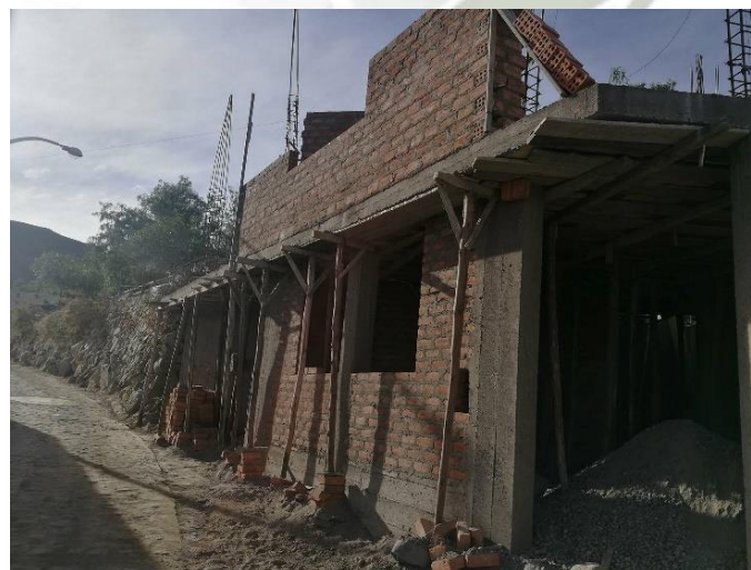
Figura 31 Toma frontal de la vivienda S-01
