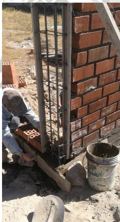
Figura 39 En la vivienda SC-03 (Izquierda) se asentaron los ladrillos sin cordel de nivel; no así en la vivienda SC-02 donde si se observa el cordel de nivel. (Derecha)
