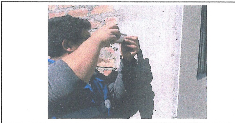
DESCRIPCION: Ensayo de Esclerometria en Columna de Confinamiento del 1° Nivel.
