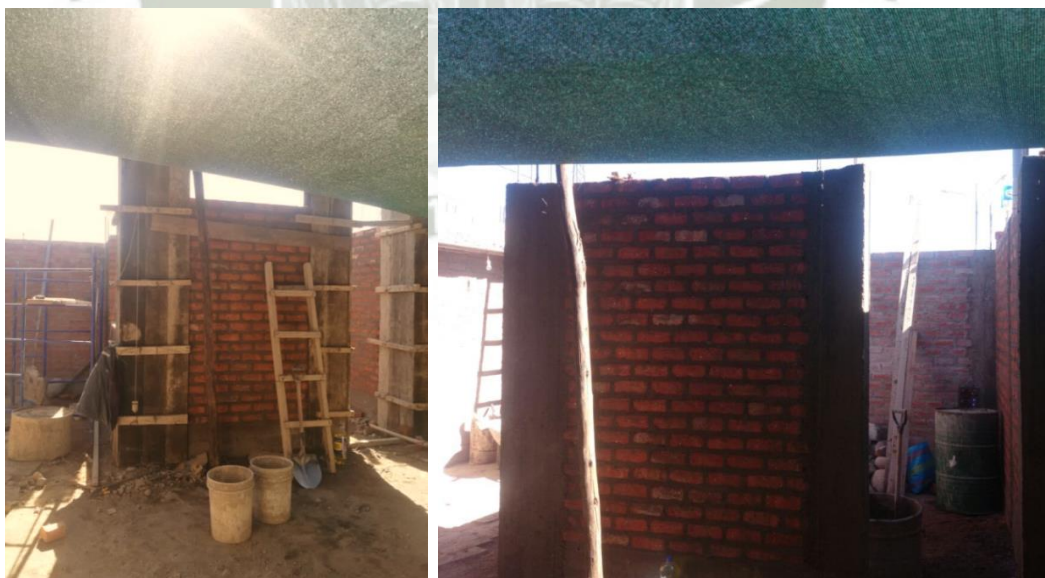
Figura 60 Columnas recién vaciadas a las 16:20 pm (Izquierda); Columnas ya desencofradas a las 8:15 am del día siguiente (Derecha).
