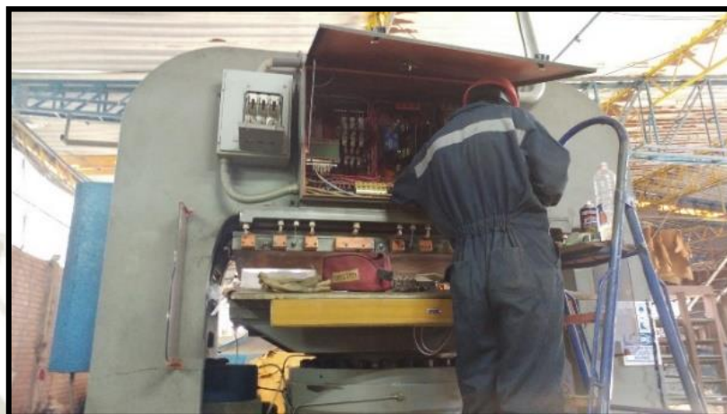
Fotografía N° 5 Mantenimiento eléctrico a Satinadora
