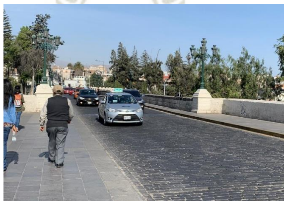
Imagen 53: Vía "Calle Puente Grau" – Vista a nivel de piso
