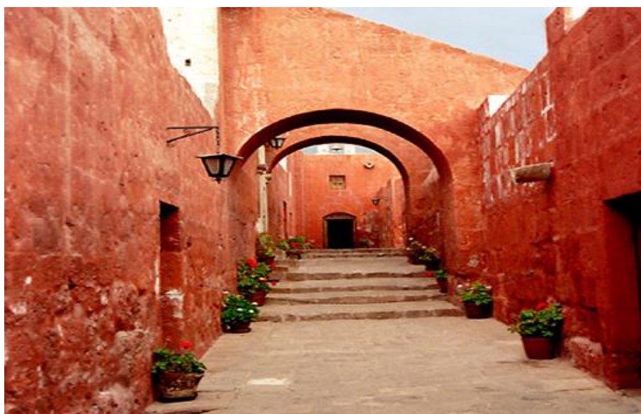
Fig. 9. Vista del Monasterio de Santa Catalina donde se aprecia la falta de rampas que dificulta el acceso de personas en sillas de ruedas
