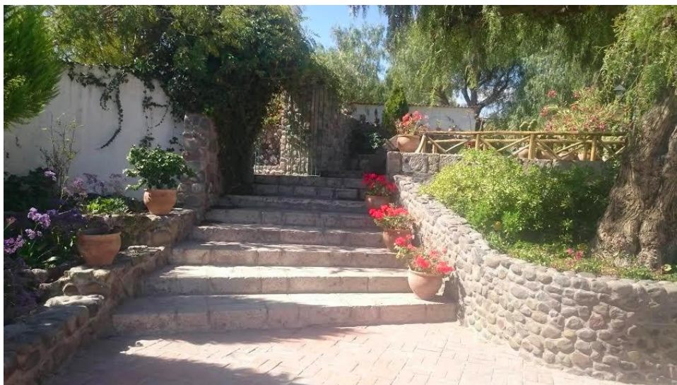
Fig. 25. Acceso a diferentes zonas del Molino de Sabandia sólo a través de numerosas gradas
