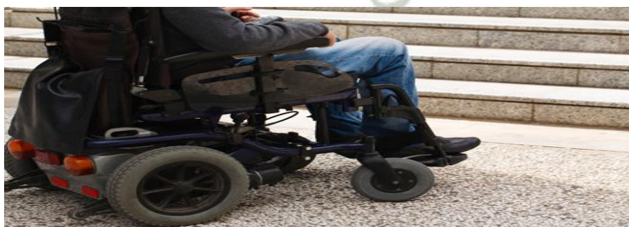
Fig. 7. Ejemplo de barrera que muestra el impedimento para acceder a un lugar determinado en silla de ruedas, por la falta de rampas.
