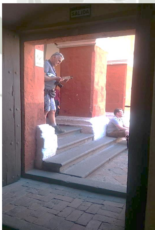
Fig. 10. Presencia de escalones y piso de adoquines que dificultan el desplazamiento en sillas de ruedas en el Monasterio de Santa Catalina.
