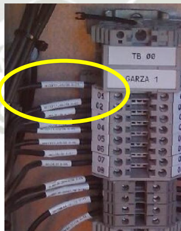
Fig. 3-78 Tagueado de cable de entrada.
