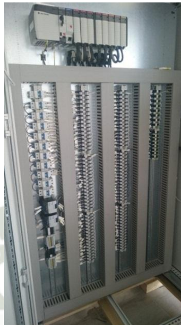
Fig. 2-3 Distribución interna de Tablero de control (ControlLogix).
