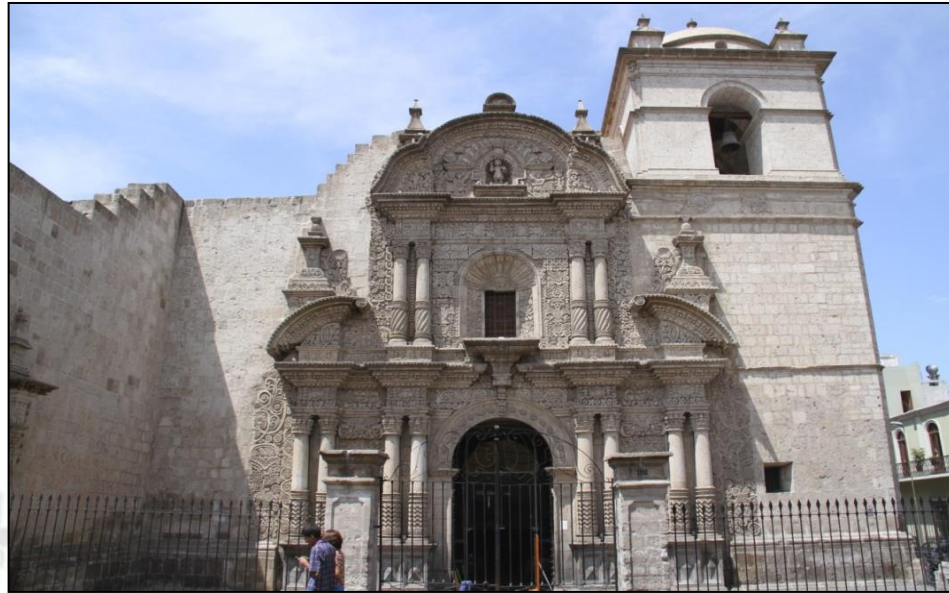
Figura N° 16. Fachada Principal de la Iglesia de la Compañía de Jesús
