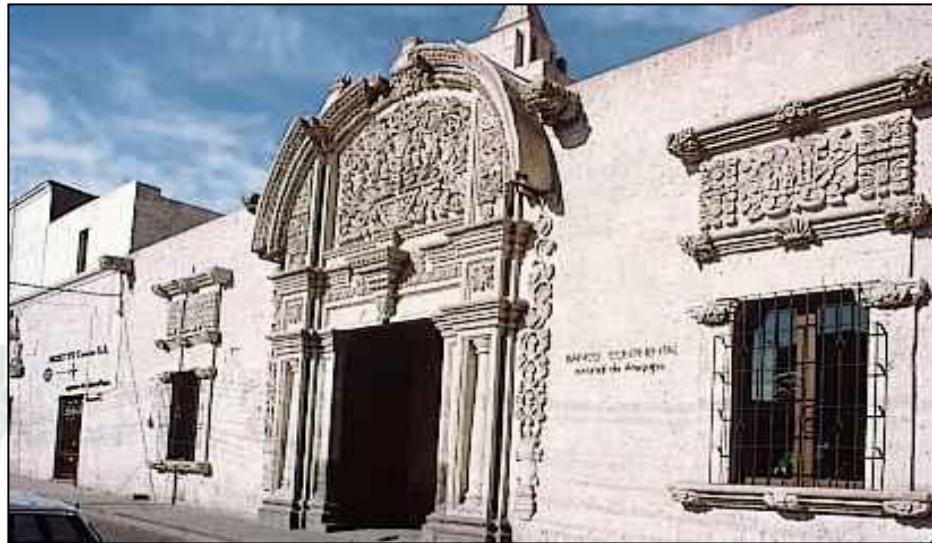
Figura N° 12. Fachada Principal de la Casona Tristán del Pozo
