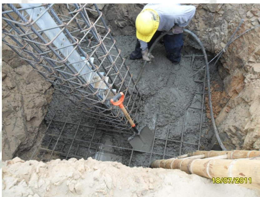
Figura 8.108: Vaciado de concreto en zapatas (Fuente: Internet)
