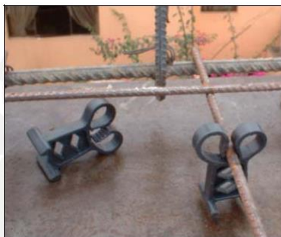
Figura 8.128: Separadores plasticos para encofrado metalico. (Fuente: Internet)
