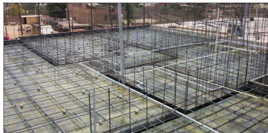
Figura 8.127: Encofrado metalico de losa. (Fuente: Internet)
