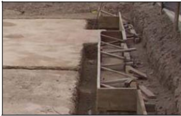
Figura 8.114: Encofrado de Frisos en losa de cimentación (Fuente: Internet)
