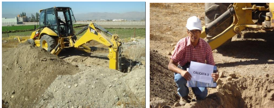
Figura 3.10: Excavacion de calicata N 3 (C-3) (Fuente: Fotografía)
