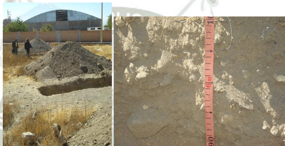
Figura 3.11: Vista de las calicatas (Fuente: Fotografía)
