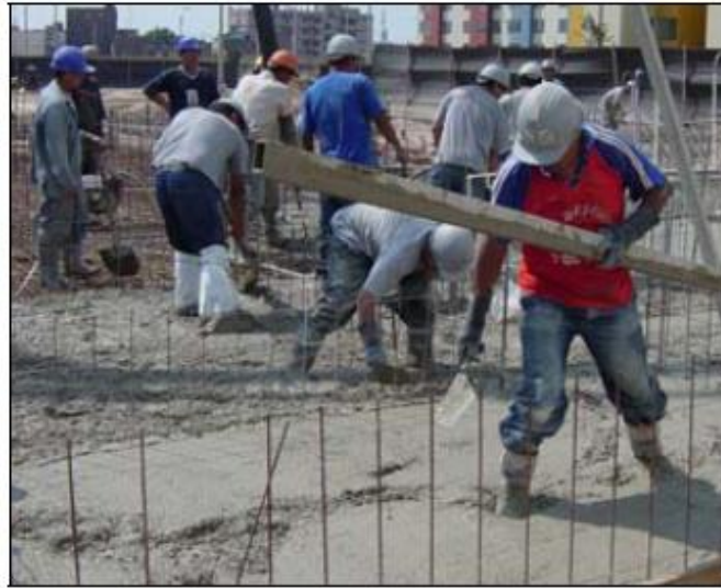
Figura 8.117: Vaciado de la cimentación (Fuente: Internet)
