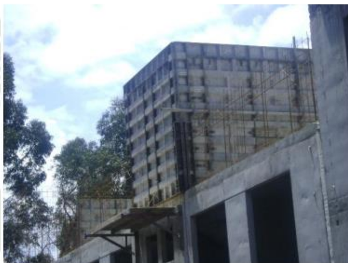
Figura 8.120: Encofrado de muros en el sistema de MDL (Fuente: Internet)
