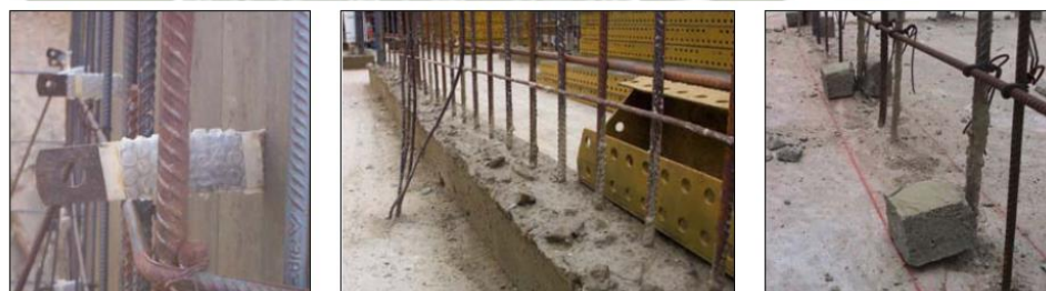
Figura 8.123: Corbatas, muretes de concreto para encofrados y dados de concreto (Fuente: Internet)
