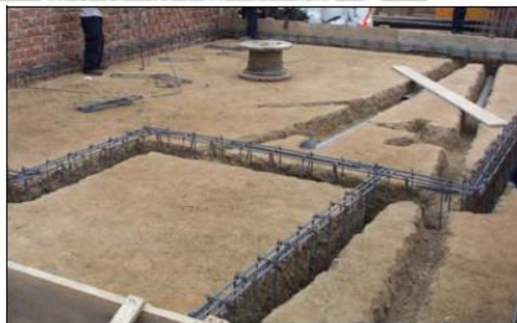
Figura 8.115: Colocado de acero en los dientes de la cimentación (Fuente: Internet)
