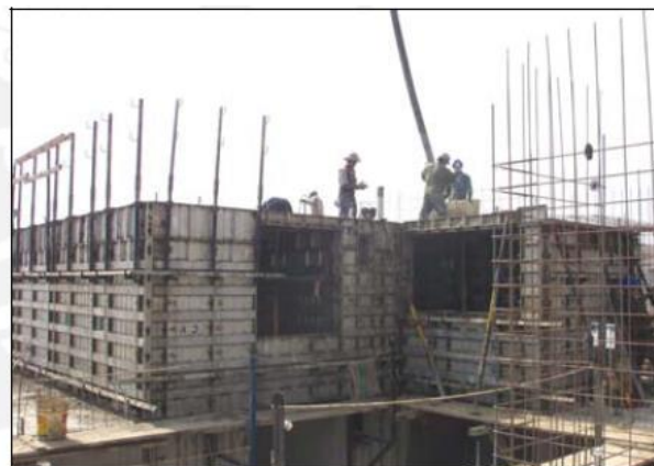
Figura 8.124: Vaciado conjunto de muros y losa (Fuente: Internet)
