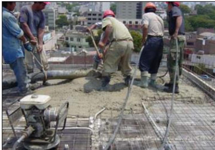
Figura 8.125: Vaciado separado de muros y losa (Fuente: Internet)
