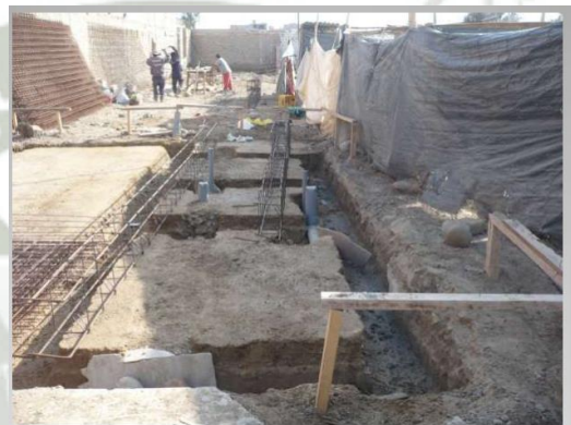
Figura 8.112: Relleno compactado (Fuente: Internet)
