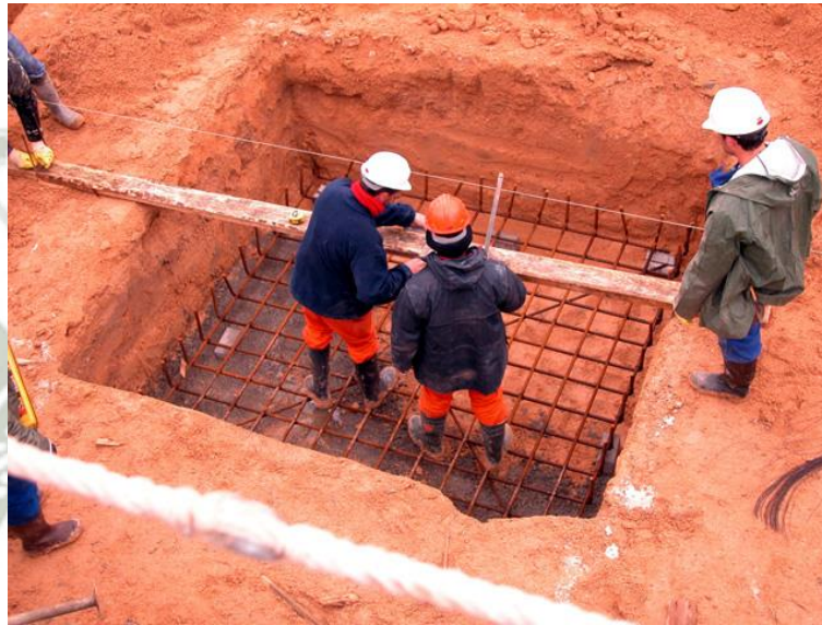
Figura 8.107: Excavación de zapatas aisladas (Fuente: Internet)
