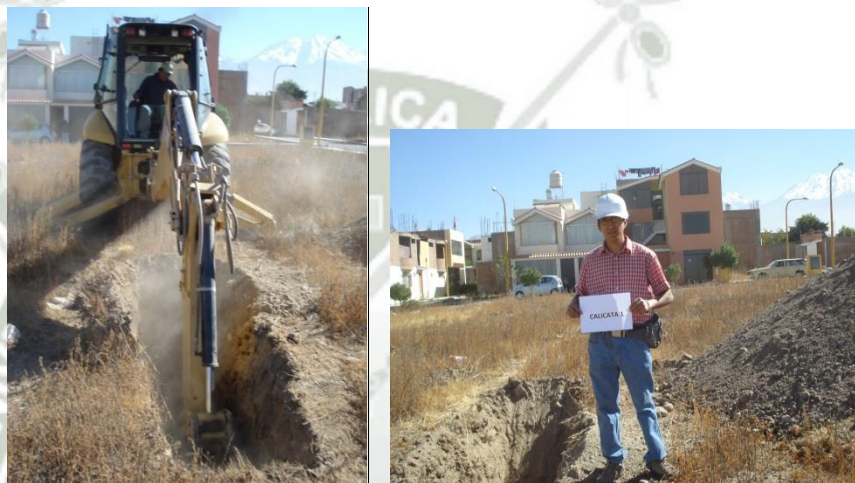
Figura 3.8: Excavacion de calicata N 1 (C-1) (Fuente: Fotografía)
