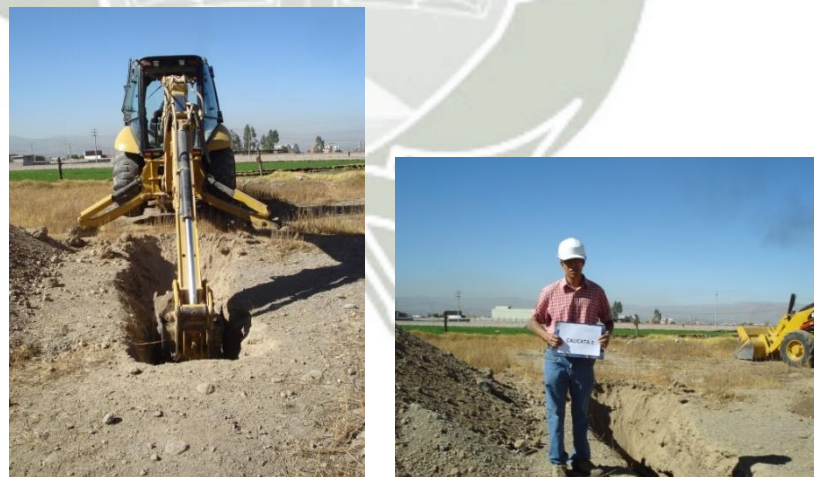
Figura 3.9: Excavacion de calicata N 2 (C-2) (Fuente: Fotografía)
