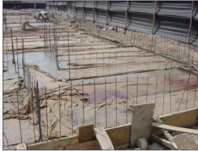
Figura 8.118: Curado de cimentación (Fuente: Internet)
