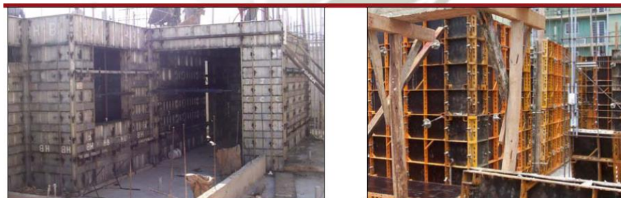
Figura 8.122: Encofrado metálicos y de madera presanda en el sistema de MDL (Fuente: Internet)
