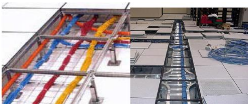
Figura 3.3: Piso falso con canaletas para la distribución de cables Fuente: www.panduit.com
