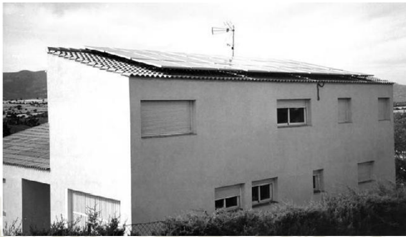
Figura 2-12. Sistema de 5 kWp, integrado a un edificio residencial (Soto del Real, Madrid, España)
