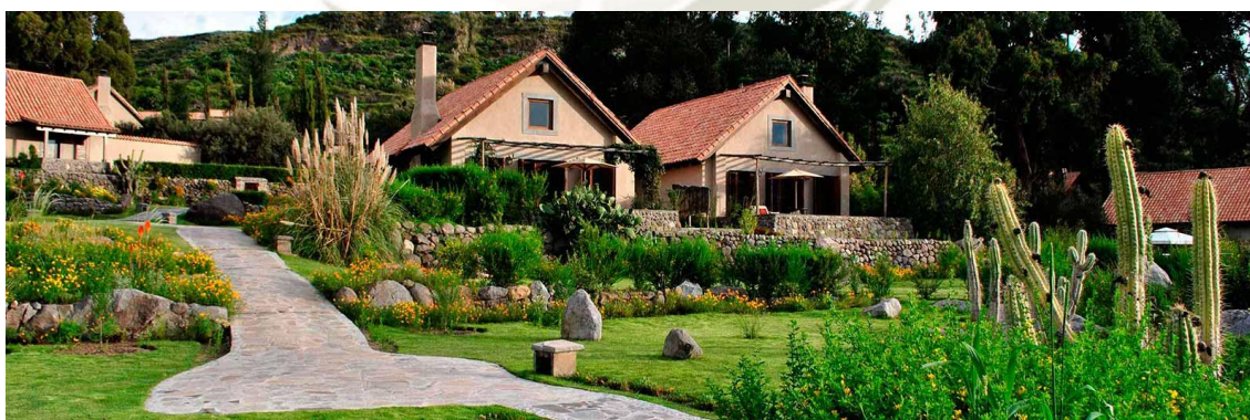
IMAGEN 39. Vista exterior de las habitaciones.
