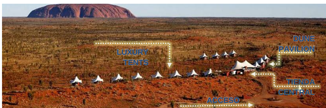
IMAGEN 25. Vista área del lodge y zonificación.
