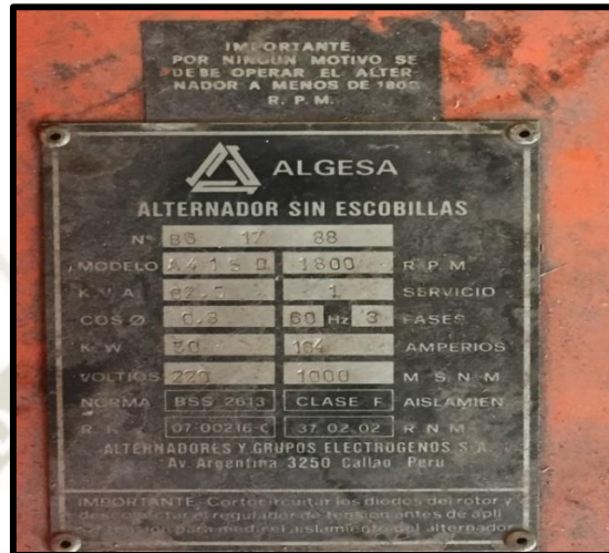
Figura 3.10. Placa de características de alternador
