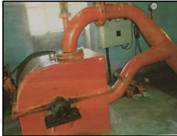
Figura 3.4. Turbina Pelton
