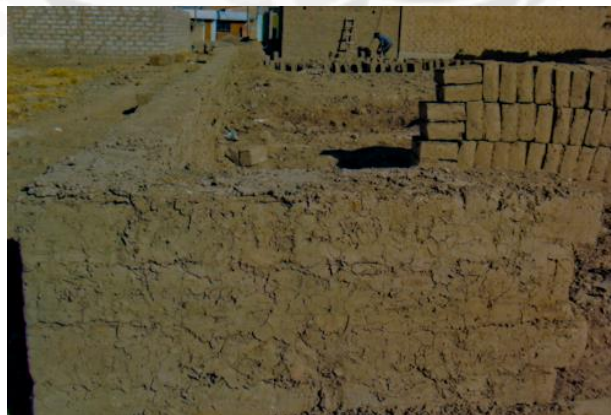
Foto 14: Muro bajo en proceso de estuque o LLutay - Fuente: propia
