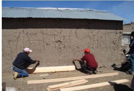
Foto 19: armando calefactor solar – Fuente: SENCICO
