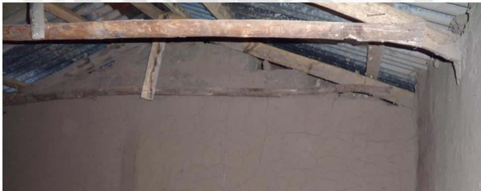
Foto 15: Vista del amarre de la estructura en madera del interior de una de las viviendas - Fuente: propia
