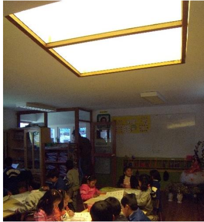
Foto 26: Ductos solares instalados en el colegio Independencia, Juliaca – Fuente: propia
