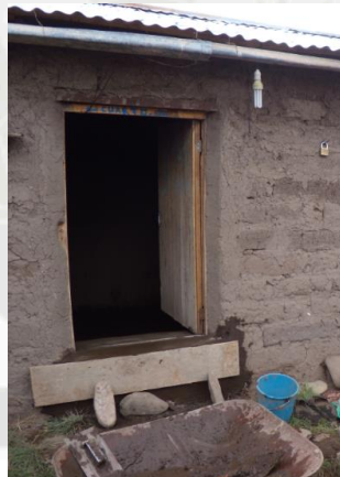
Foto 50: Vista a una de las puertas de la vivienda – Fuente: propia
