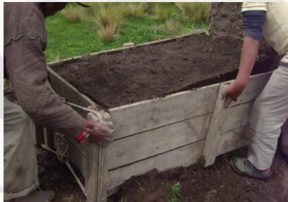
Foto 10, Desencofrado del tapial. - Fuente: propia
