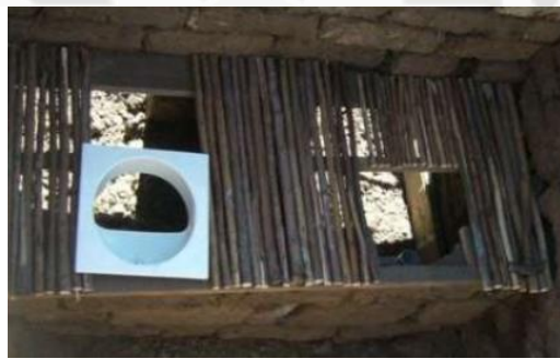
Foto 32: construcción baño seco – Fuente: rotaria del Perú SAC
