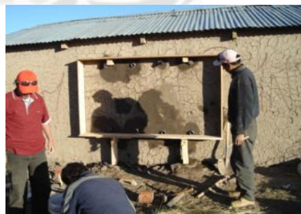
Foto 20: armando calefactor solar – Fuente: SENCICO
