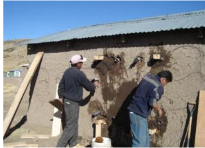
Foto 21: armando calefactor solar – Fuente: SENCICO
