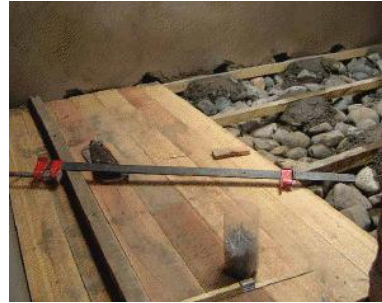
Foto 34: instalación piso – Fuente: casa solar Espinar Cusco
