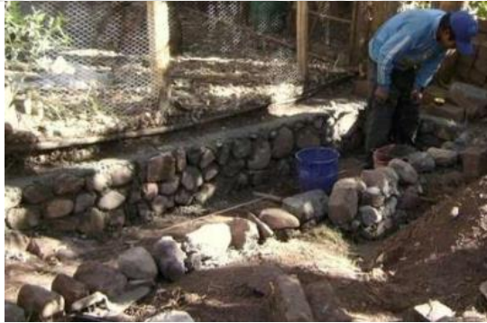
Foto 30: construcción baño seco – Fuente: rotaria del Perú SAC
