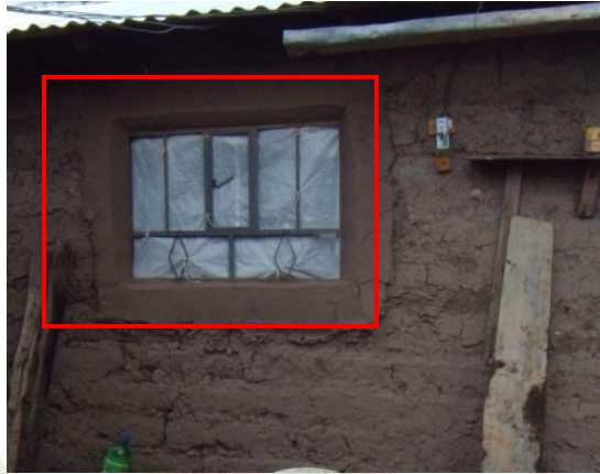
Foto 49: Vista a una de las nuevas ventanas – Fuente: propia
