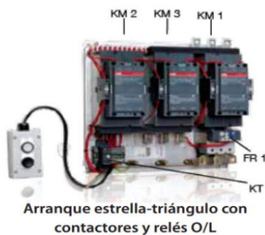
Figura 17 Arranque Estrella-Delta
