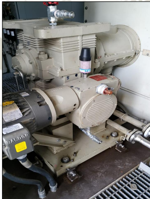
Figura 5. Reductor de velocidad marca Koenig Engineering Inc. modelo KE100-55T-5.
