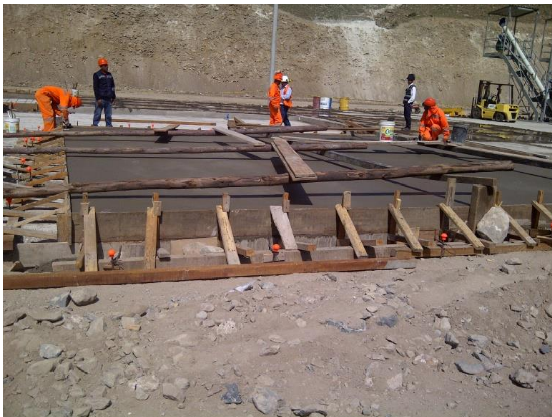
Foto 06: Ampliación de losa
