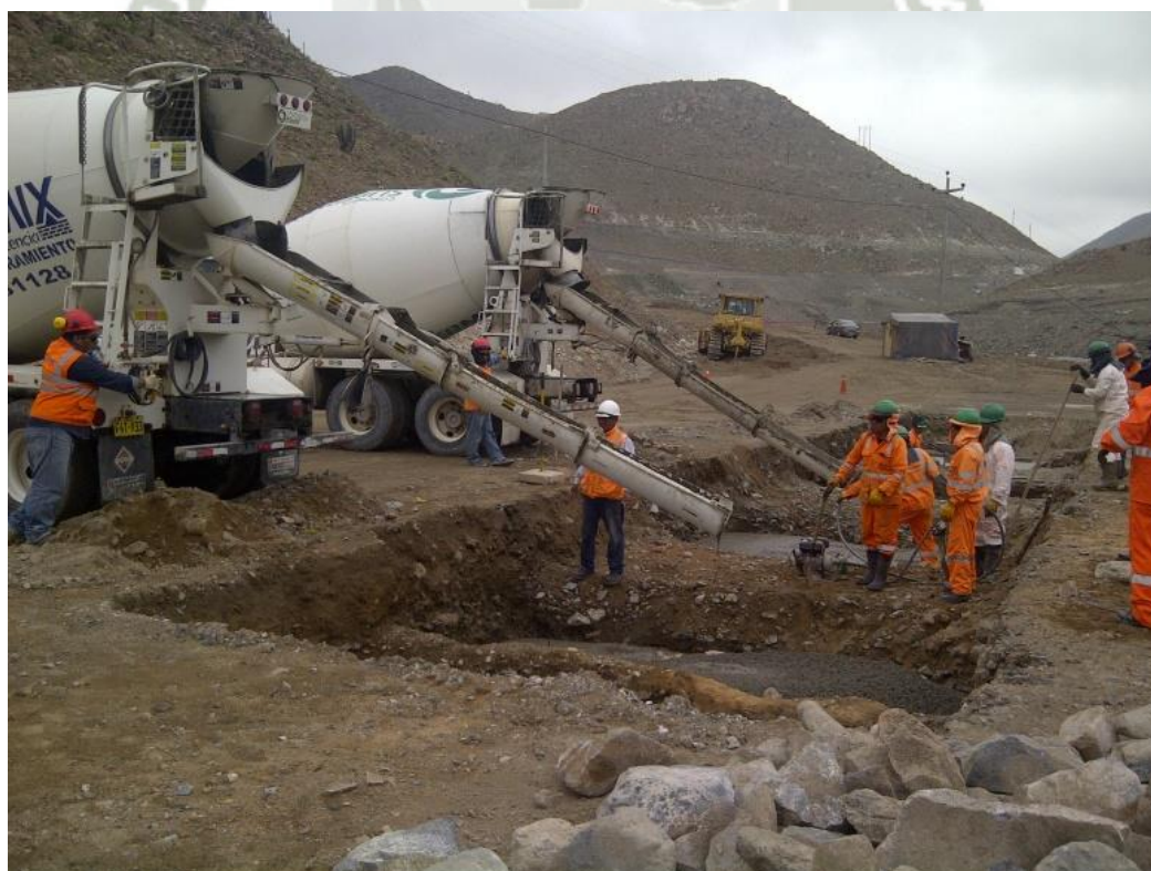
Foto 05: Cimentación de balanza
