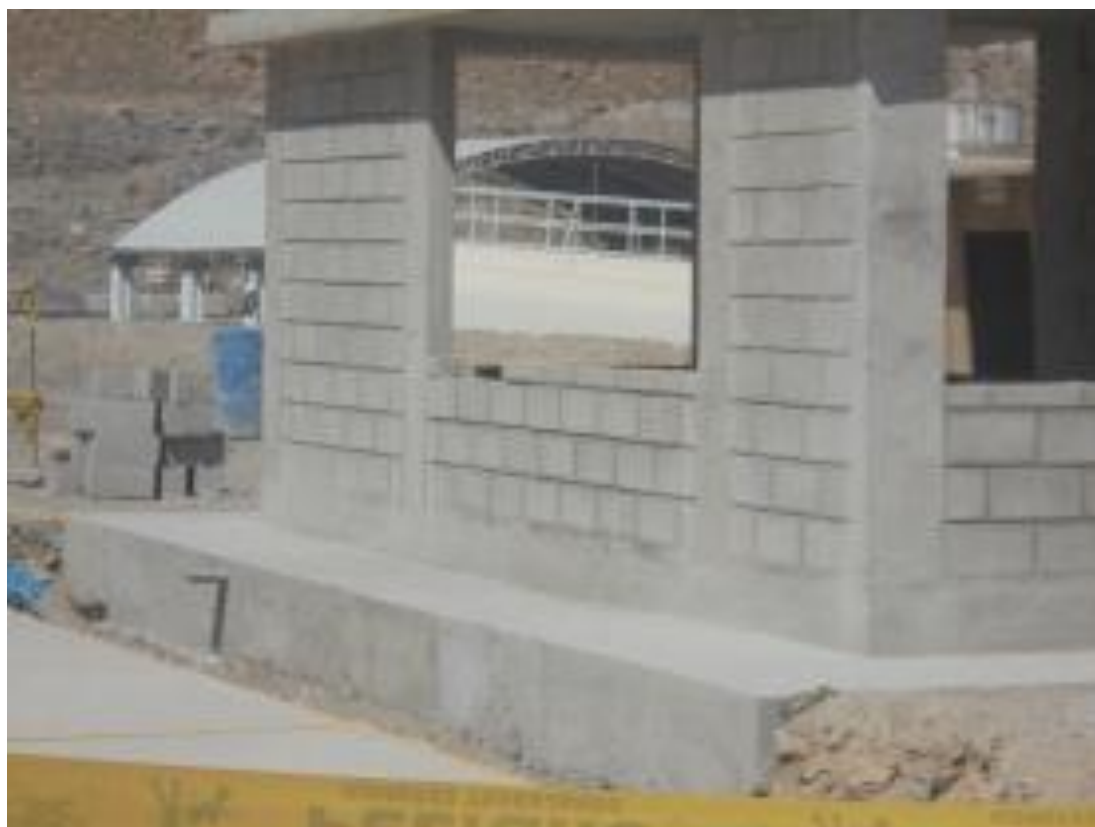
Foto N°02: Caseta zona balanza
