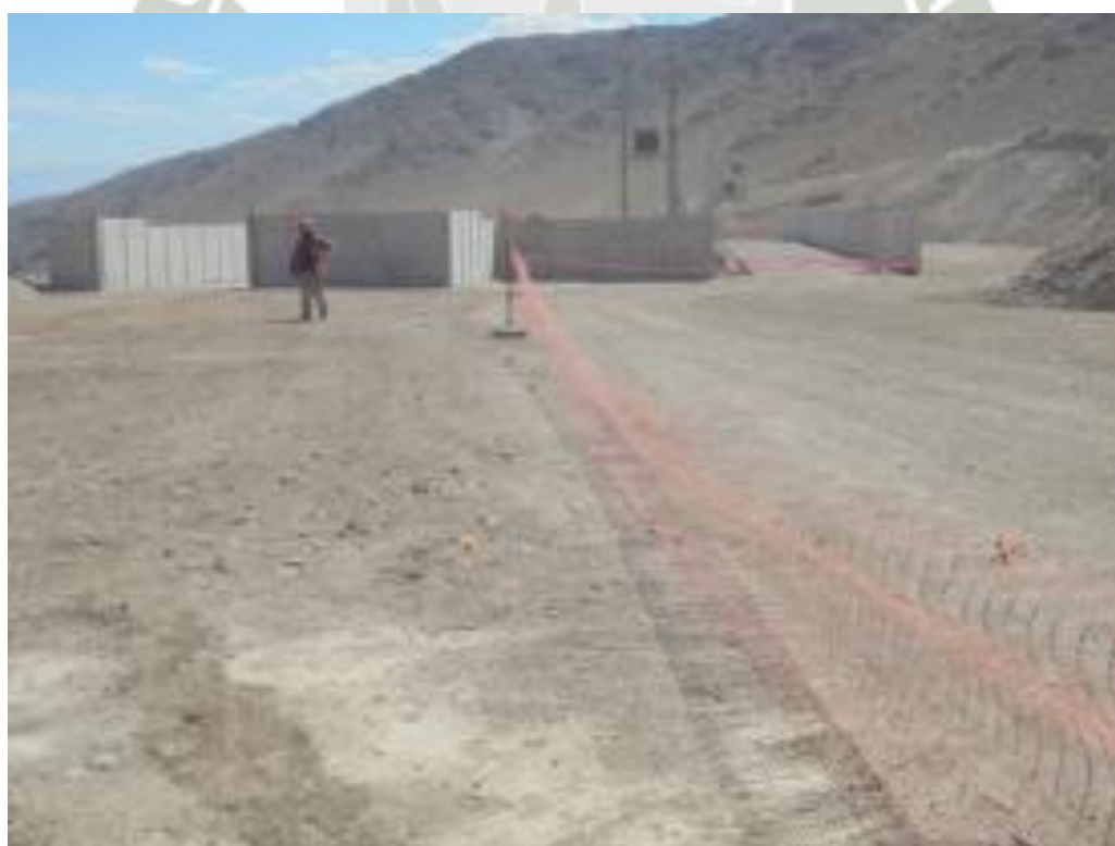
Foto N°03: Vía 2, cerco perimétrico planta de cal
