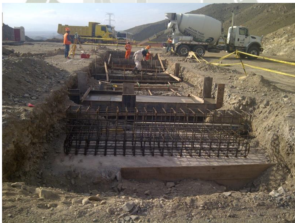
Foto 09 Armado de acero en balanza
