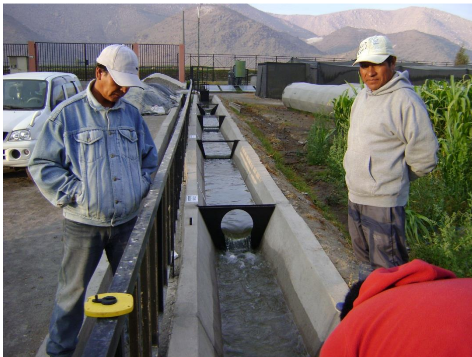
FOTOGRAFÍA No. 26. Distribución de Vertederos en Canal.
