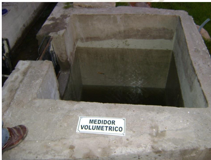
FOTOGRAFÍA No. 32. Reservorio para el método volumétrico.
