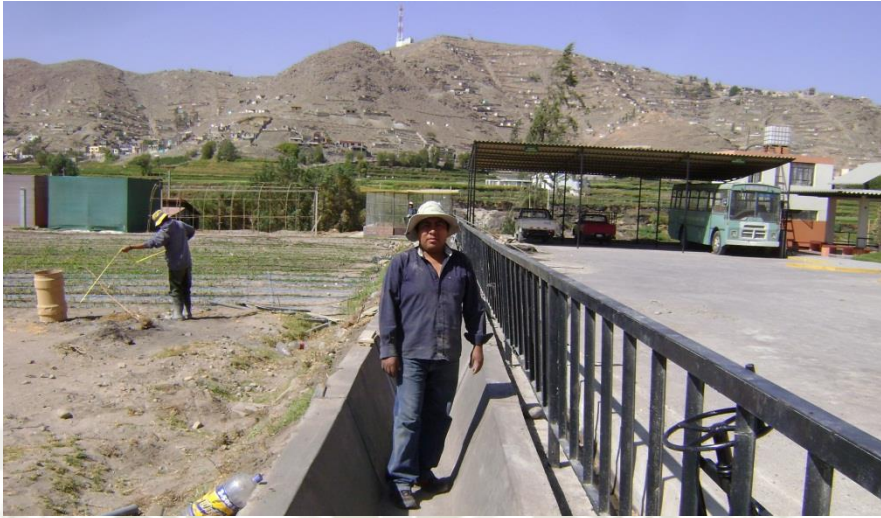
FOTOGRAFÍA No. 20. Construcción de Canal.
