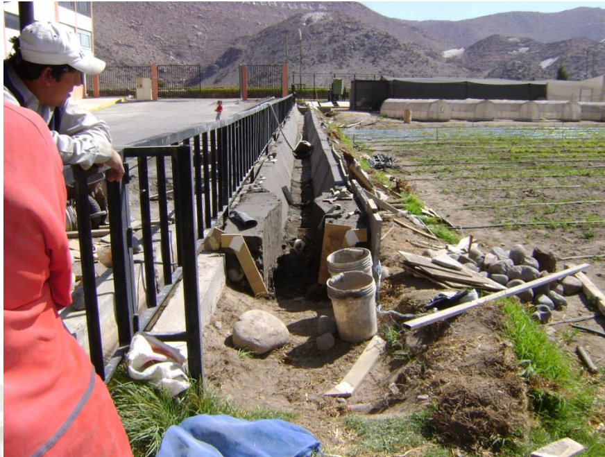
FOTOGRAFÍA No. 17. Concreto de Canal.
