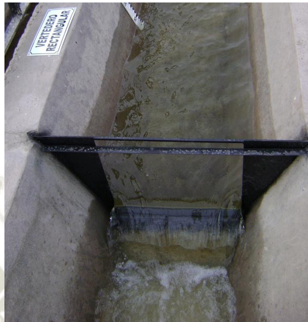
FOTOGRAFIA No. 09. Instalación vertedero de pared delgada.
