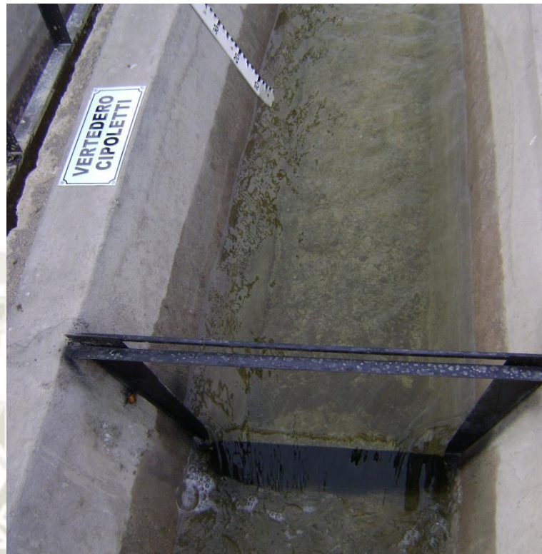
FOTOGRAFÍA No. 24. Vertedero Cipoletti.
