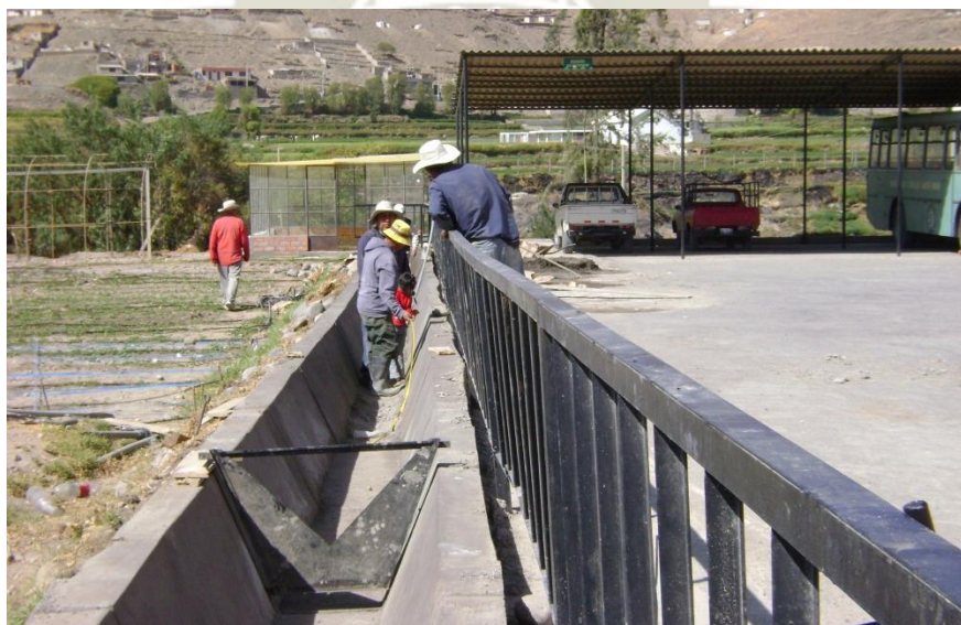
FOTOGRAFÍA No. 18. Proceso de curado de Canal.
