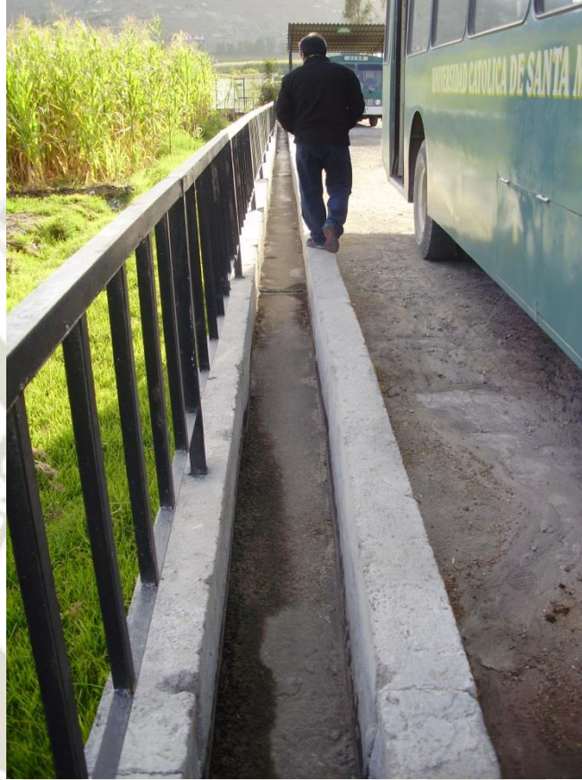
FOTOGRAFÍA No. 33. Canal de conducción.
