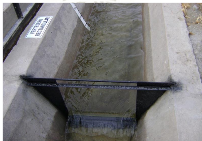
FOTOGRAFÍA No. 23. Vertedero Rectangular con contracción.
