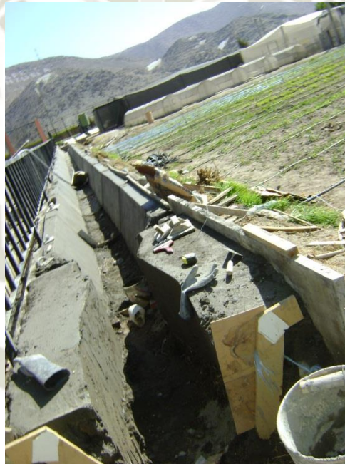
FOTOGRAFÍA No. 16. Encofrado de Canal.
