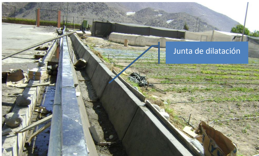
FOTOGRAFÍA No. 19. Ubicación de Juntas de Dilatación.
