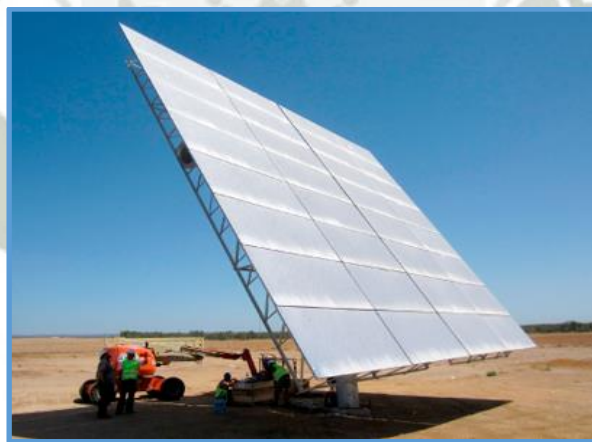
Figura N° 2.29: Detalle de un Heliostato
