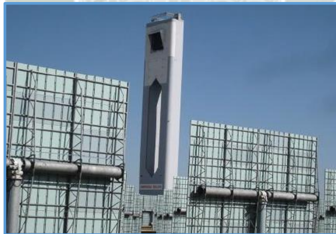
Figura N° 2.26: Receptor de cavidad
