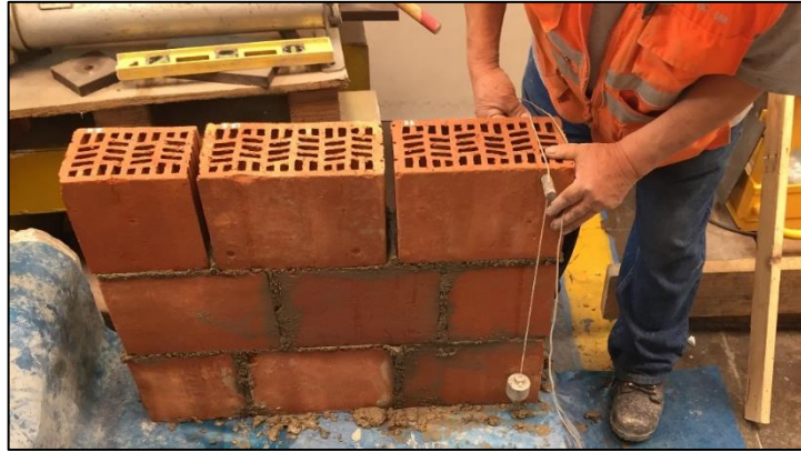
Figura 83: Control de la verticalidad del murete.
