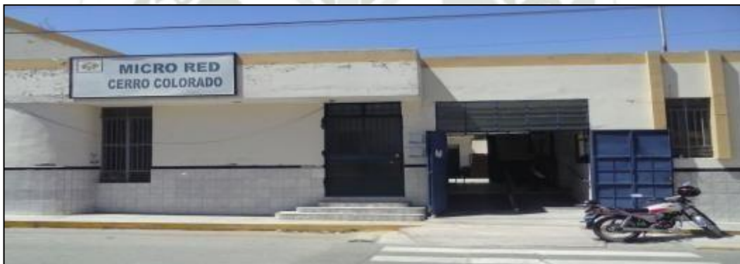
Figura 2 Vista delantera del Centro de Salud Cerro Colorado
