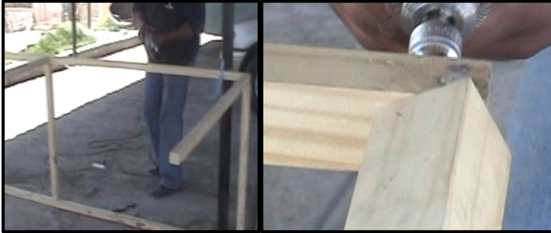
Fotografía 6: Conexión y empalme, parte superior e inferior del armazón.
