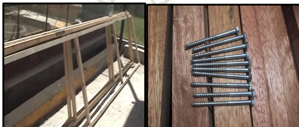
Fotografía 5: Construcción de los cajones, uso de Tirafones.
