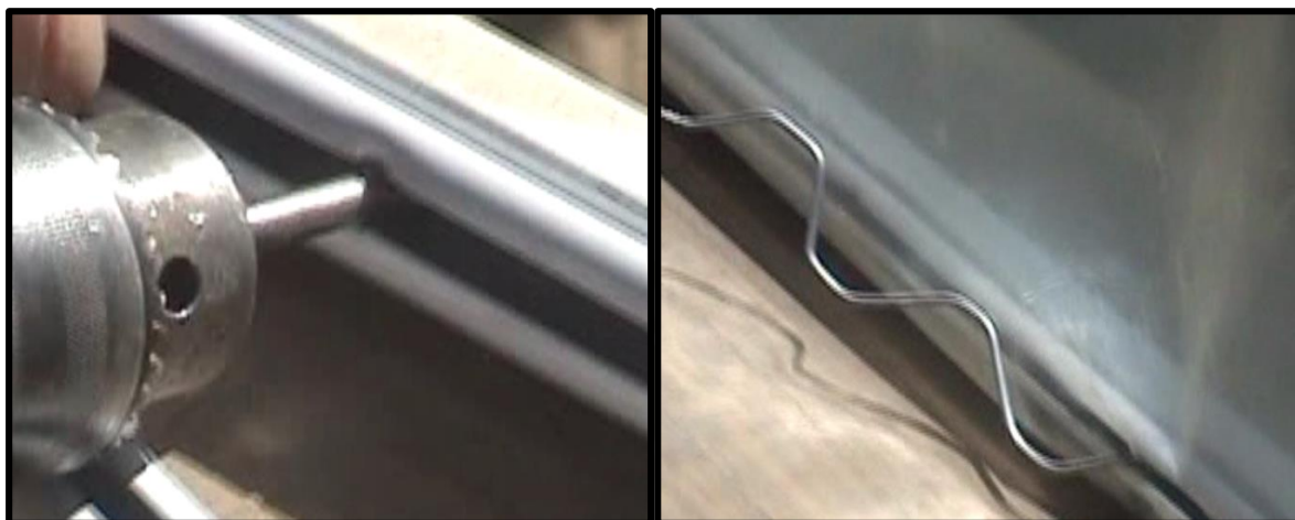
Fotografía 3 y 4: Técnica de colocado y ajustate del agrofilms.
