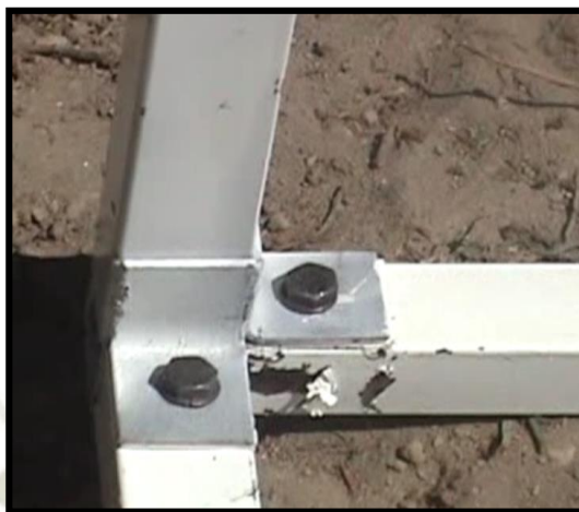
Fotografía 1: “L” metálica para acoplamiento de las piezas.
