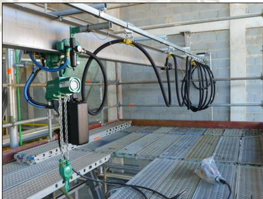
Fig. 26. Posicionamiento Neumático de Polipasto en instalación Temporal. Fuente: Propia Autor: Basurco y Orihuela
