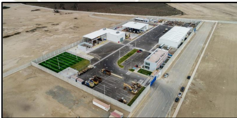
Figura 3 Centro de Reparación y Distribución Central - CRDC Empresa San Martín Generales S.A.
