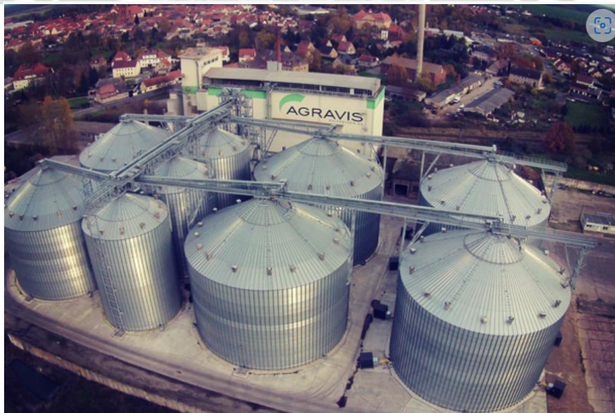
Figura 2-6: Silos de almacenamiento de soya de 5500 m 3 de capacidad en Alemania 2010
