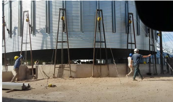
Figura 5-3: Montaje de Silos de granos de 2000 Toneladas Argentina
