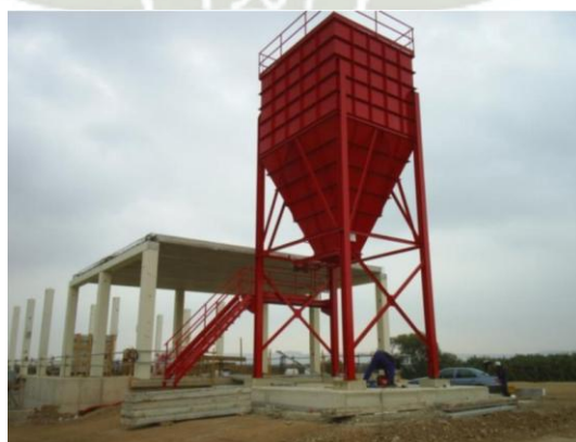
Figura 2-3: Silo de sección rectangular con tolva tronco-piramidal inferior
