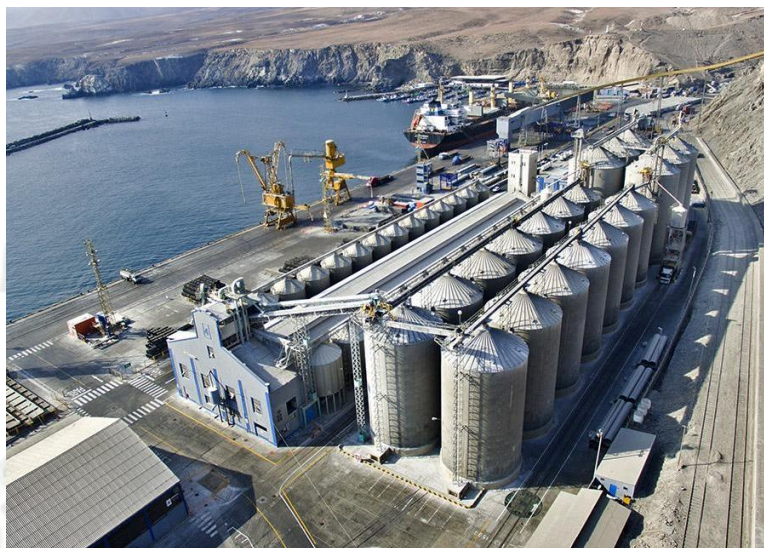
Figura 1-7: Silos de Almacenamiento capacidad material granel 75000 TM
