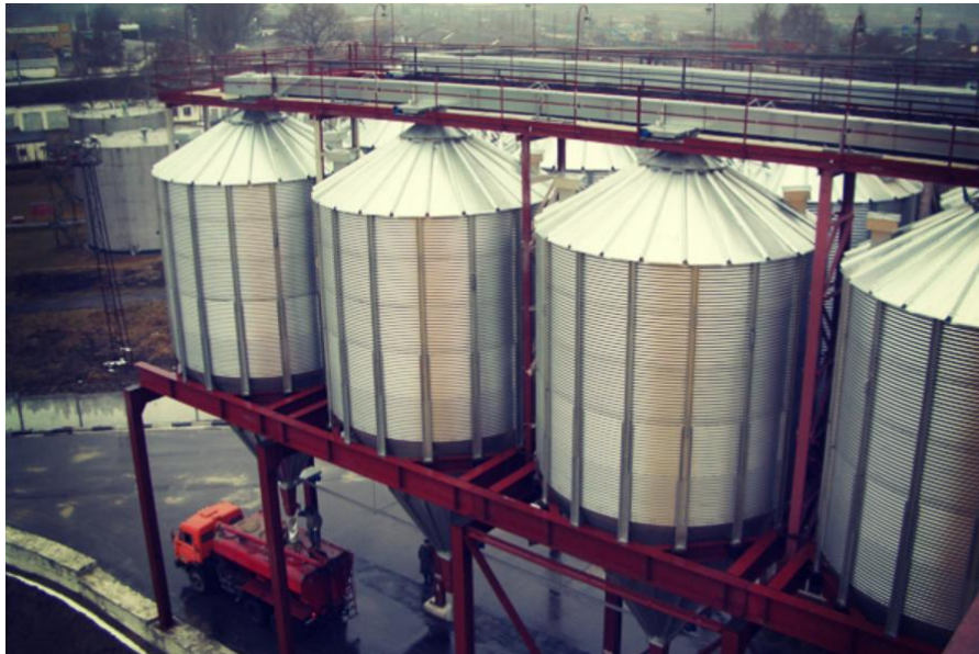
Figura 2-5: Silo descarga a camiones de trigo en Serbia
