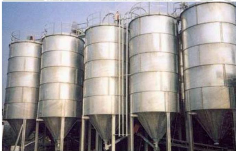
Figura 2-1: Silos de sección circular y pared de chapa lisa.
