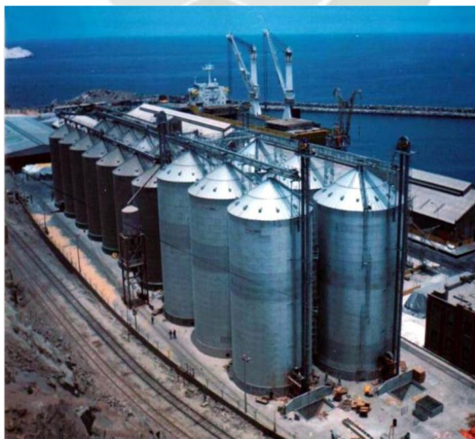
Figura 2-9: Baterías de Silos B y C
