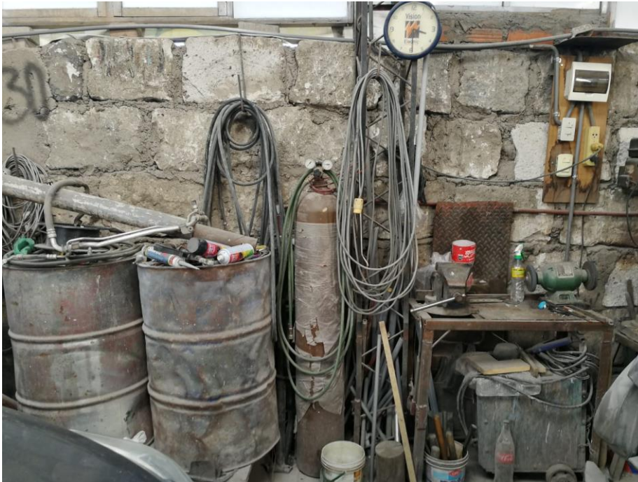
Figura 44 Zona de tanques y conexiones
