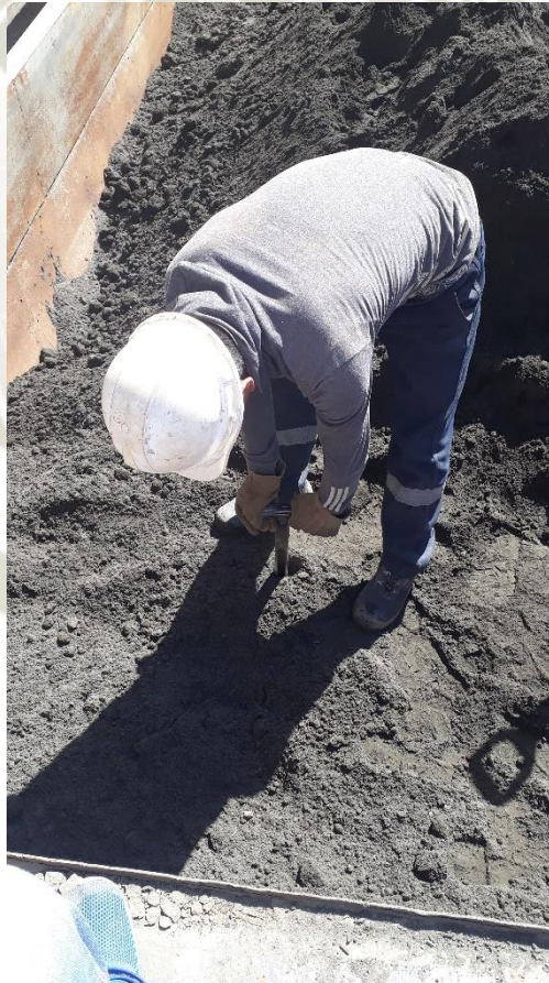
FOTO 6: Muestreo final de mineral
