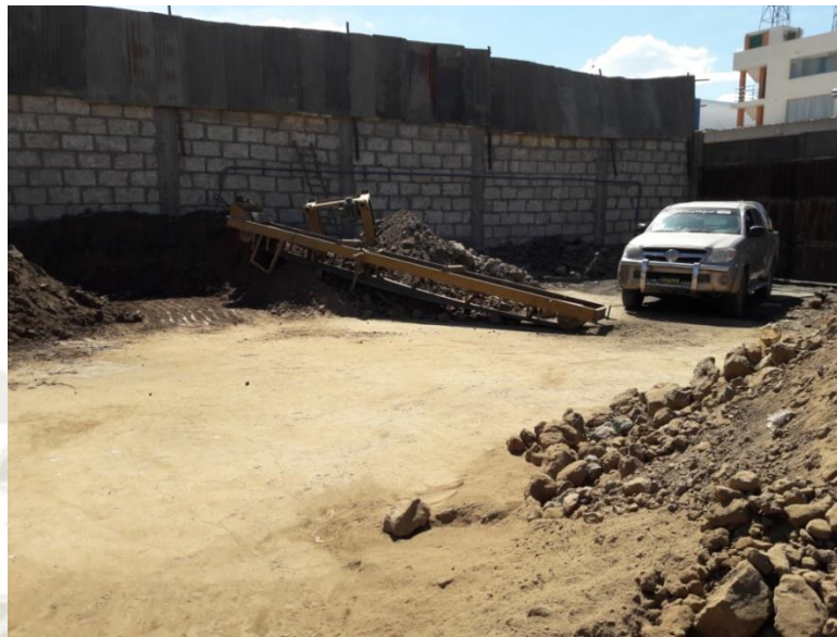
FOTO 15: Vista zona de ingreso
