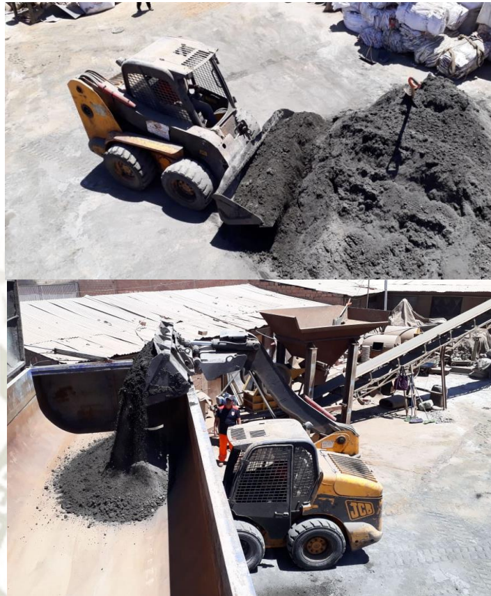
FOTO 19: Bobcat en diversos trabajos
