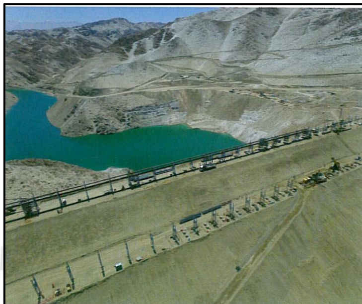
Figura 22. Presa de Relaves Fuente: La Empresa SMI Inc.
