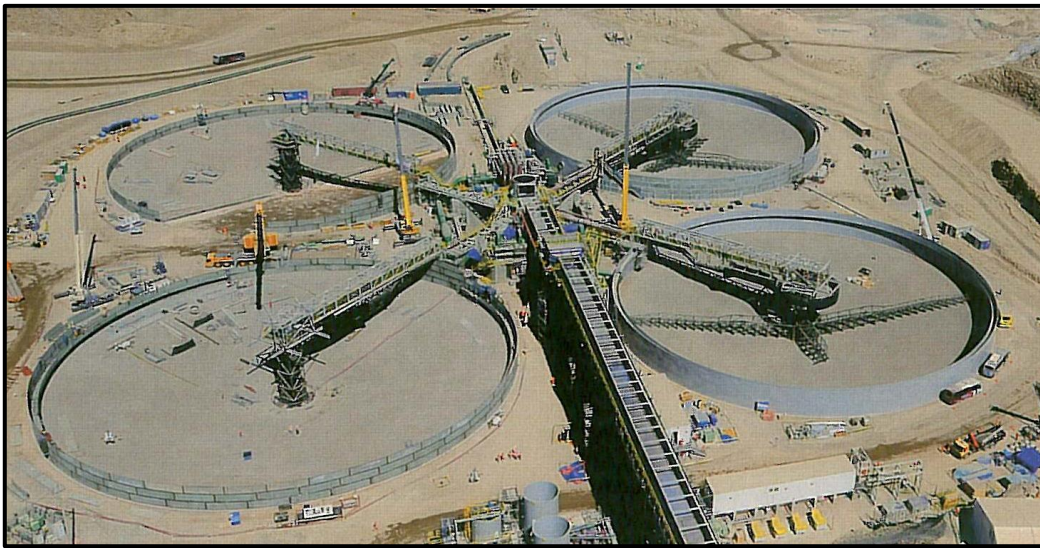
Figura 20. Área de Espesadores Fuente: La Empresa SMI Inc.
