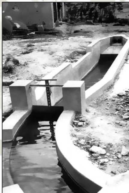
Figura 2.15: Ejemplo de un desarenador al inicio de un canal
