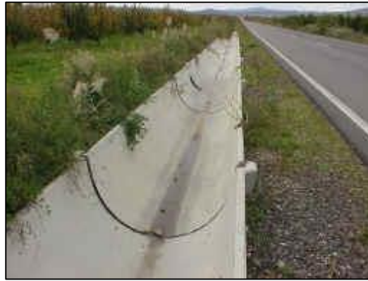
Figura 2.10: Canal tipo parabólico
