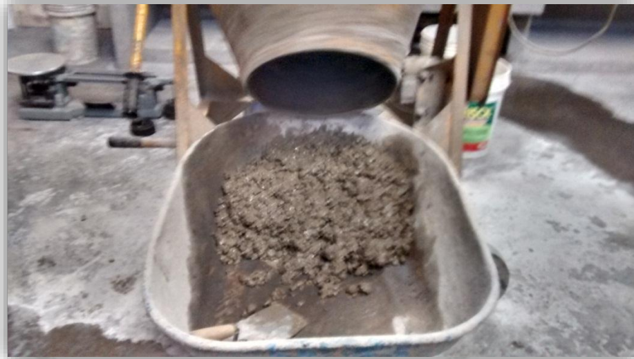
FIGURA 3.5: MEZCLA DE CONCRETO EN CARETILLA
