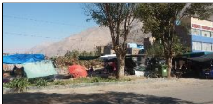
Foto N° 5.11: parte Frontal del terreno, falta de mantenimiento Fuente: Elaboración propia.
