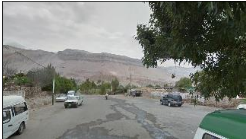
Foto N° 5.20: Vía salida a Huancarqui, sin consolidar, en mal estado, falta de señalización y no existe mobiliario urbano.
