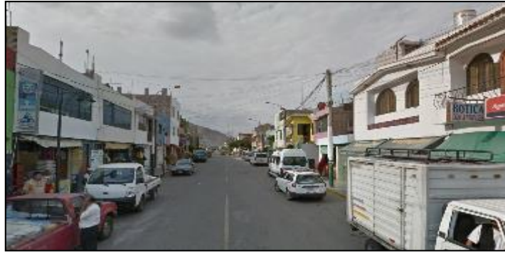
Foto N° 5.16: Vía intermedia principal de transporte de personas que sirve como paraderos, originando caos vehicular, es la de mayor transitabilidad vehicular, vía simple de doble sentido, en regular estado mantenimiento, sin señalización horizontal ni vertical.
