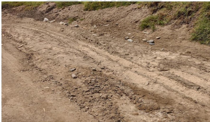
Figura 7 Condición de la Vía
