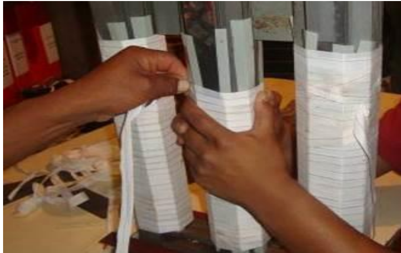
Figura 42: Prensado de las columnas con cinta poliéster
