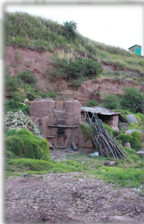
Foto 27: Horno artesanal sin techo, ni cubierta, ni chimenea; se observa el combustible apilado a los costados
