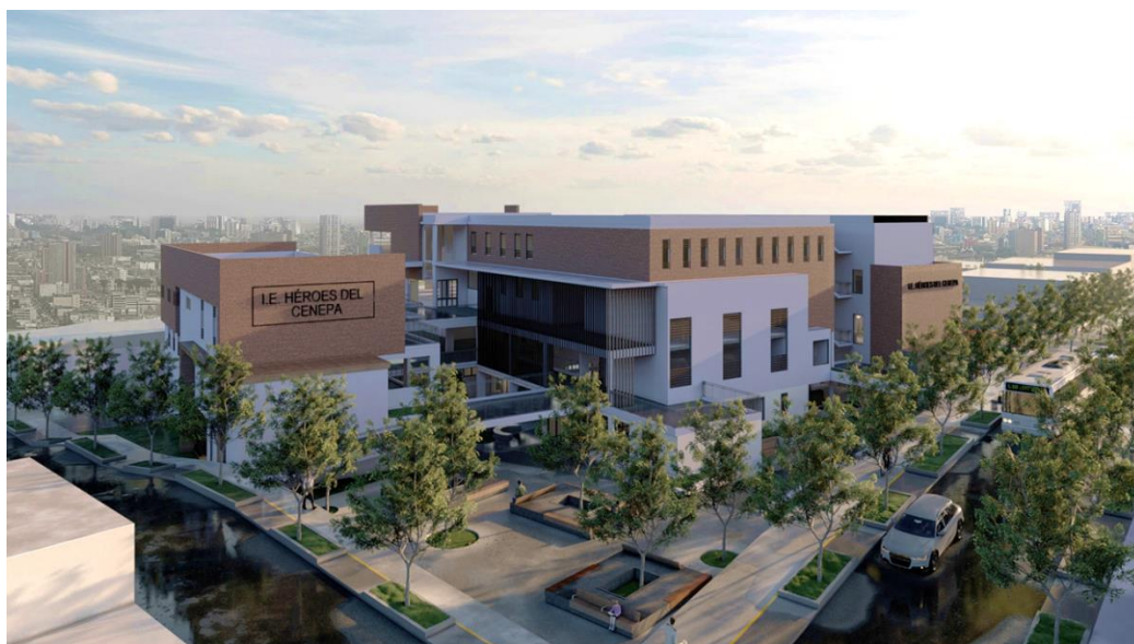
Figura 196 Fachada ingreso - principal
