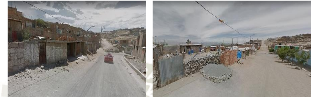
Figura 65 Áreas no consolidadas, vías sin asfaltar
