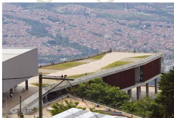
Figura 13 Superficie de un espacio usado como espacio colectivo
