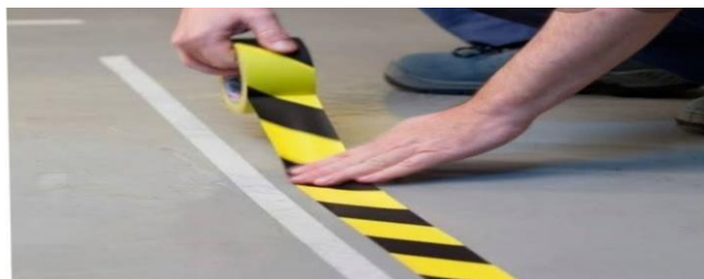
Figura 47. Muestra la cinta amarilla necesaria para la señalización de zonas en el Almacén Muestras. Adaptación propia en base a la investigación realizada.
