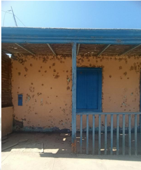
Figura 39. Columna en la vivienda C.P.C.-B1.1
