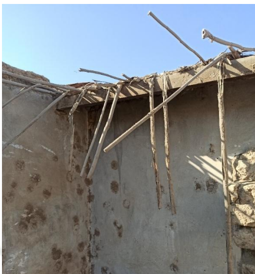
Figura 37 Viga de la vivienda C.P.C. 1002
