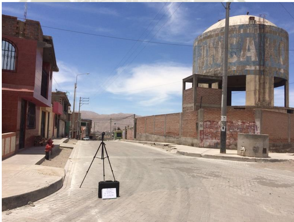
Figura 30. Estación de monitoreo de ruido ambiental R-2 durante la etapa de construcción del proyecto.
