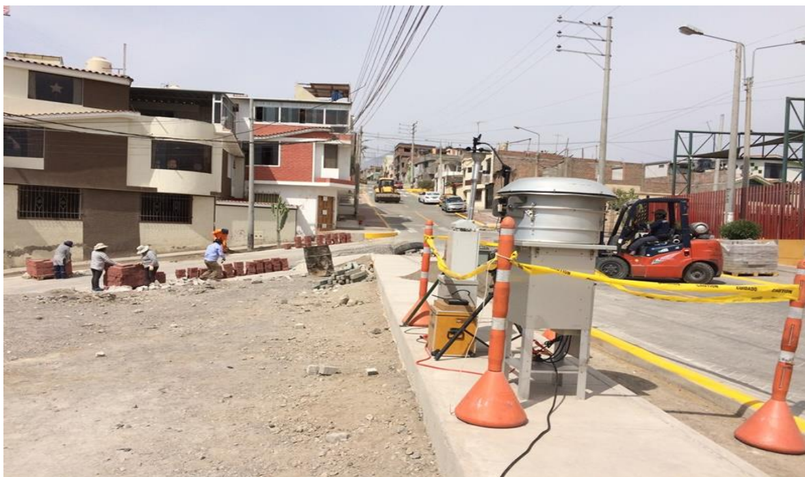
Instalación de Equipos de Monitoreo de Aire(HI-VOL, BGI, Tren de Muestreo)
