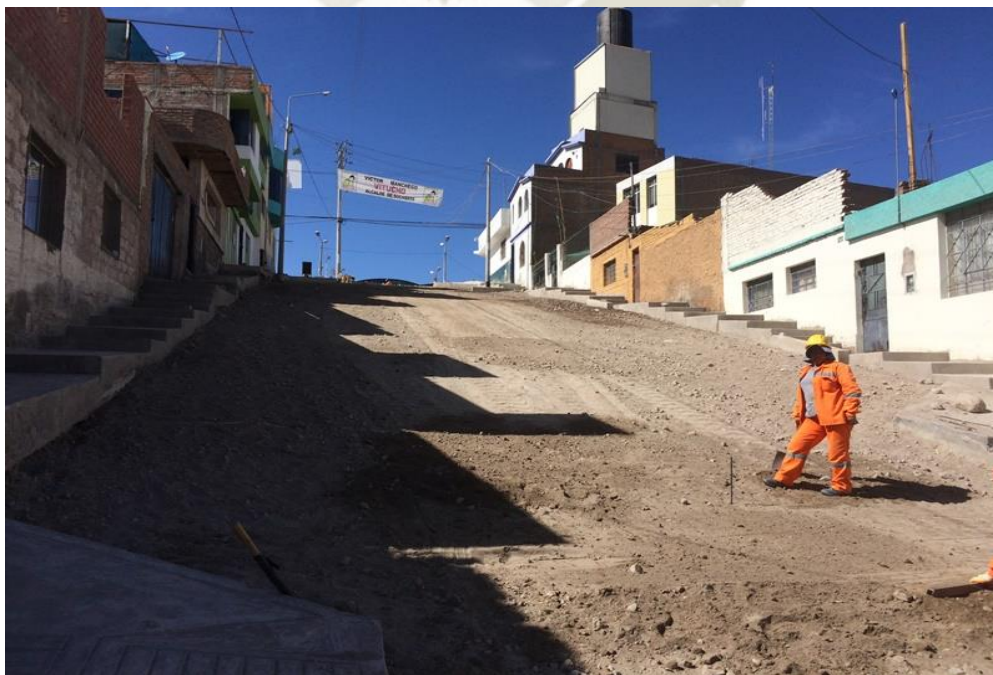
Figura 23. Suelo de las calles descubiertas durante la ejecución del proyecto.
