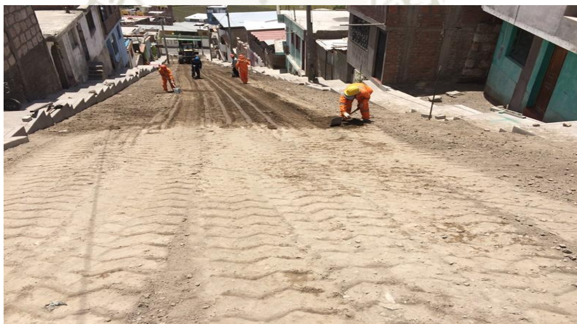
Vista –Movimiento de Tierra
