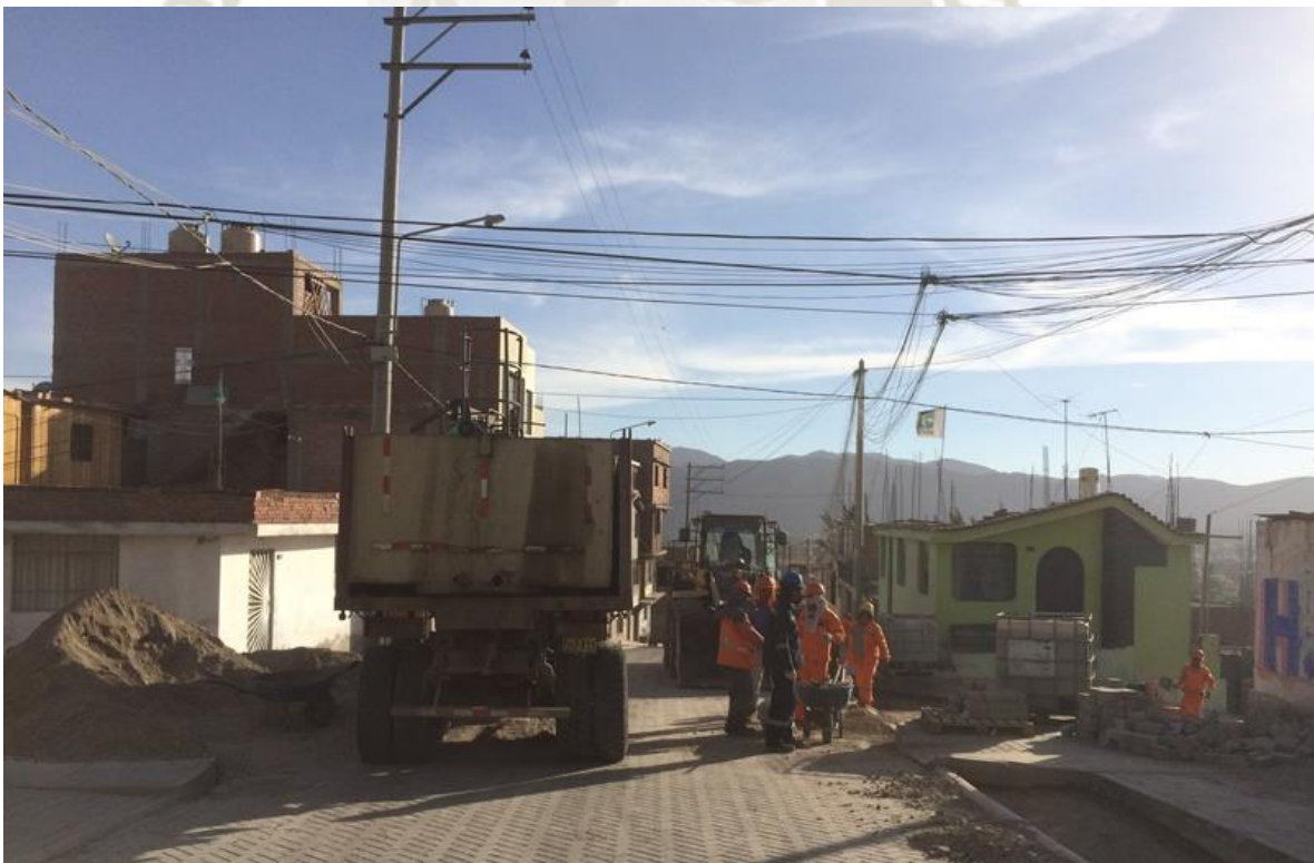
Movimiento de Maquinaria
