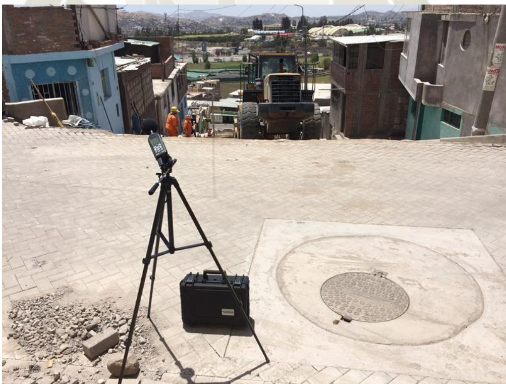
Figura 32. Estación de monitoreo de ruido ambiental R-4 durante la etapa de construcción del proyecto.
